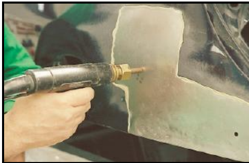
Figura 42. Aplicación de calor con el electrodo de cobre
