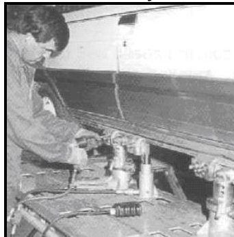
Figura 75. Montaje de mordazas de anclaje.
