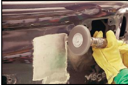
Figura 38. Eliminación de la pintura.
