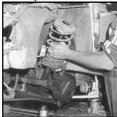
Figura 85. Desmontaje del semieje.
