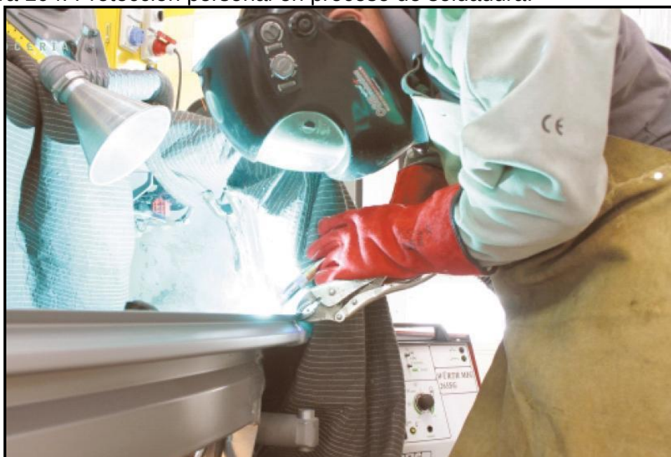
Figura 104. Protección personal en proceso de soldadura.
