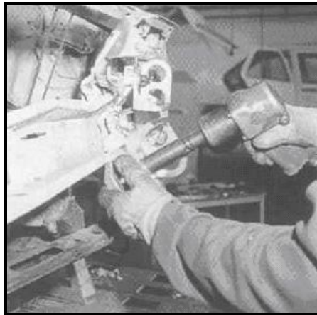
Figura 80. Instalación de mordazas.
