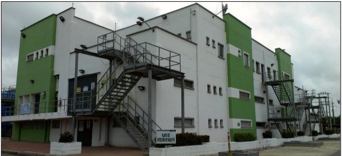
Figura 21. Planta de inyección de agua (PIA).
