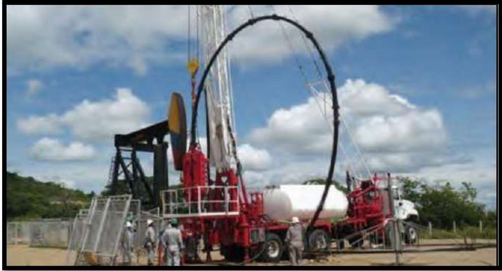
Figura 9. Instalación de varilla continua.
