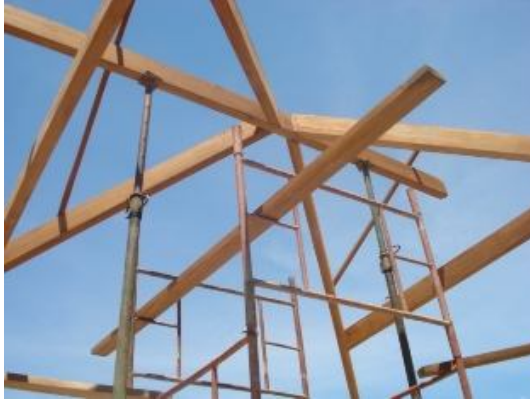
Estructura de carga
