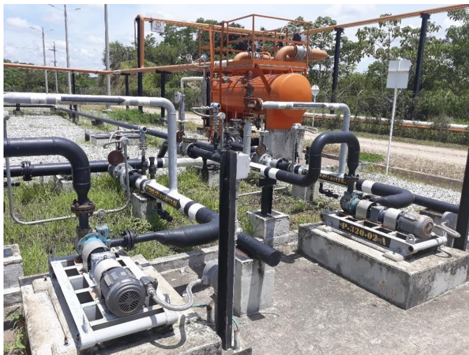
Figura 29. -K.O. Drum proceso Gas Tea.
