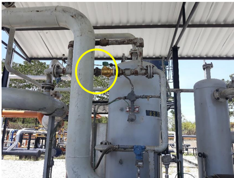
Figura 22. Ubicación válvula solenoide VRU-EISA.
