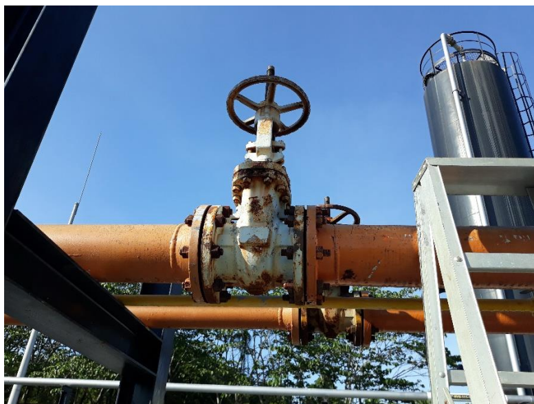
Figura 19. Válvula línea de succión entrada VRU-EISA.
