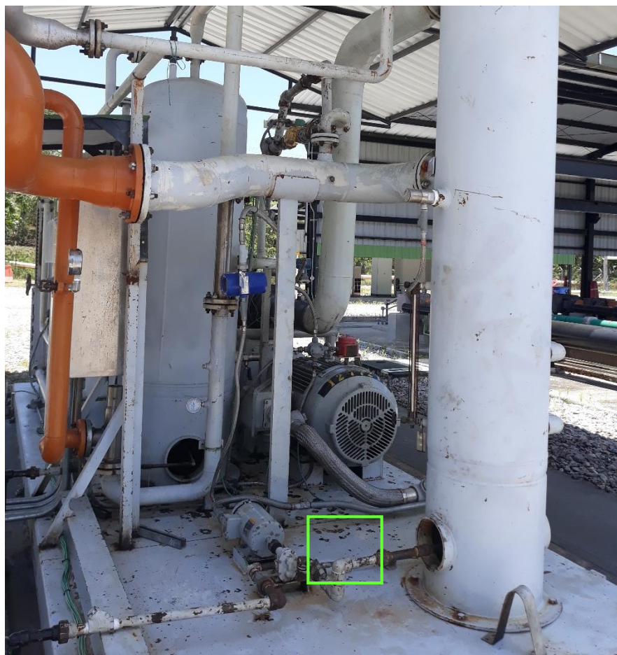
Figura 25. Posible ubicación de trampa de condensados en VRU-EISA.
