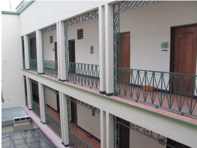
Figura 3. Oficinas Sedes Bucarica
