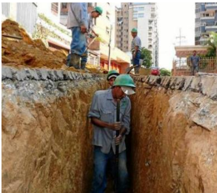
Figura 18. Zanja para alcantarillado. Fuente: el autor.
