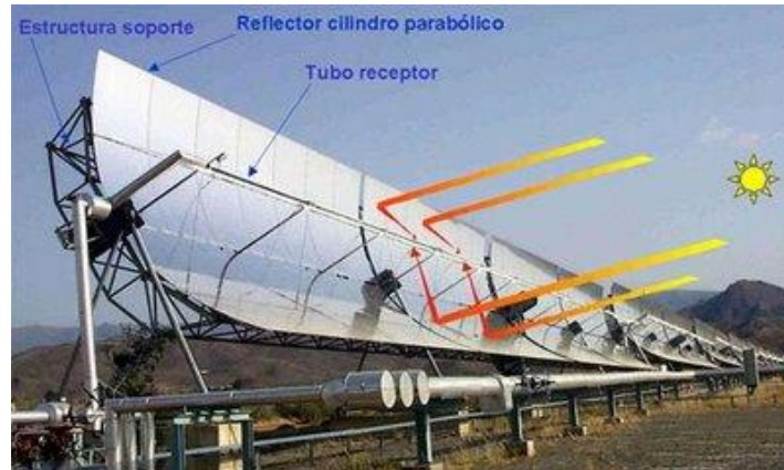
Figura 109 Elementos Principales de los Colectores Cilindro Parabólicos
