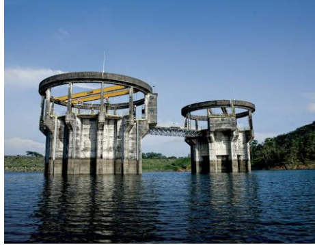
Figura 199 Central Hidroeléctrica San Carlos
