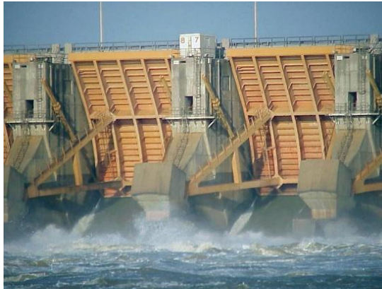
Figura 177 Compuerta tipo Taintor
