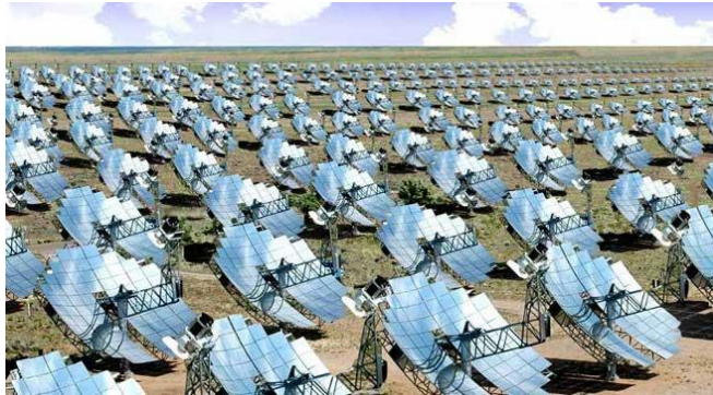
Figura 111 Sistema de discos Stirling para una central termoeléctrica de alta temperatura
