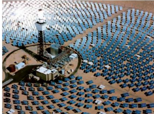
Figura 102 Sistema solar con torre y heliostato
