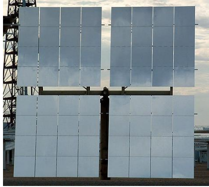
Figura 115 Heliostato de la central solar termoeléctrica Solar Two (California, Estados Unidos)
