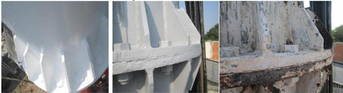
Foto 3 Proyecto Mantenimiento de Torres
