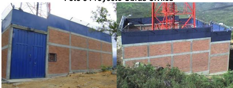
Foto 5 Proyecto Obras Civiles
