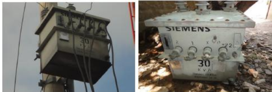
Foto 2 Proyecto Mantenimiento Eléctrico
