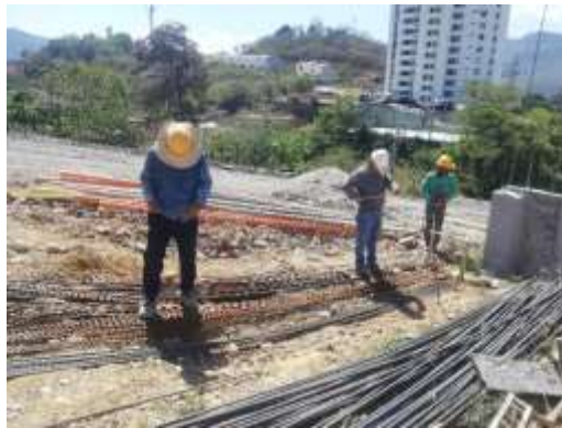
Figura 2. Replanteo o trazo de la torre 14
