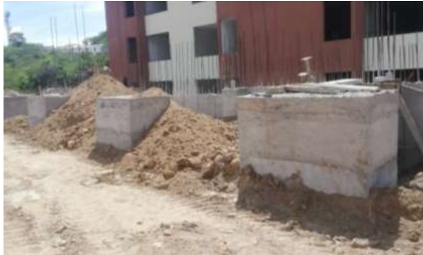
Figura 4. Pilotes concretos ciclópeo hasta nivel de cimentación
