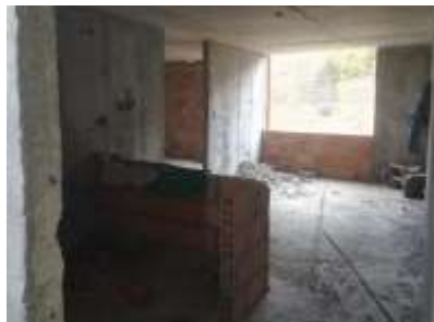
Figura 23. Mampostería de apartamento
