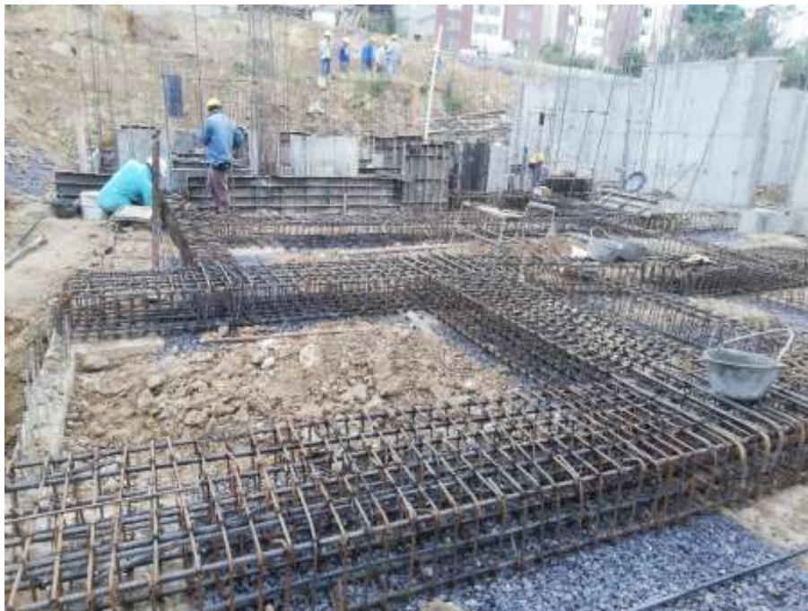
Figura 15. Colocacion de acero
