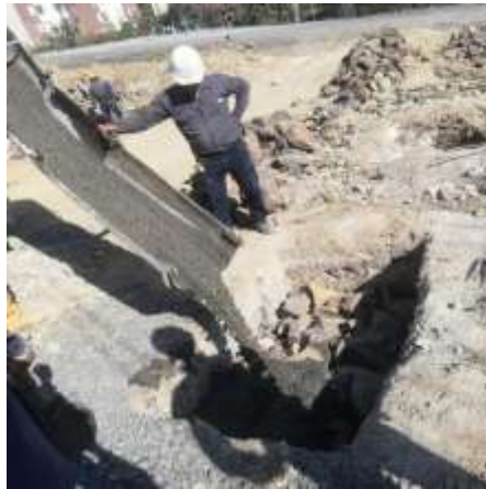
Figura 3. Excavacion para pila de concreto ciclópedo.
