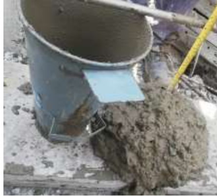
Figura 16. Control prueba asentamiento del concreto.
