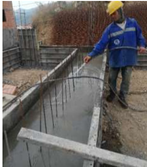
Figura 10. Curado de vigas de cimentación.
