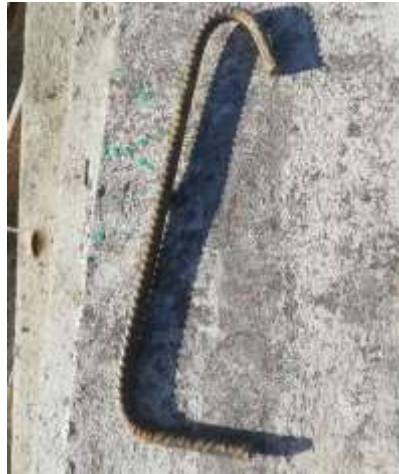
Figura 13. Gancho suplementario para vigas y columnas
