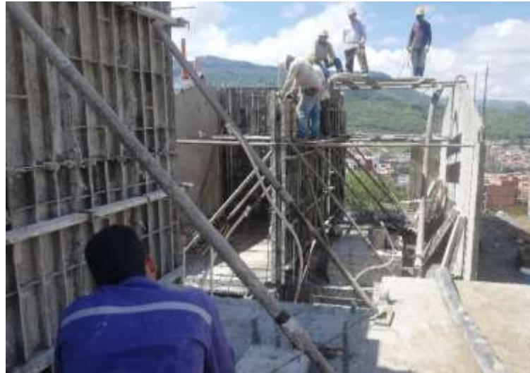
Figura 6. Encofrado de muros estructurales
