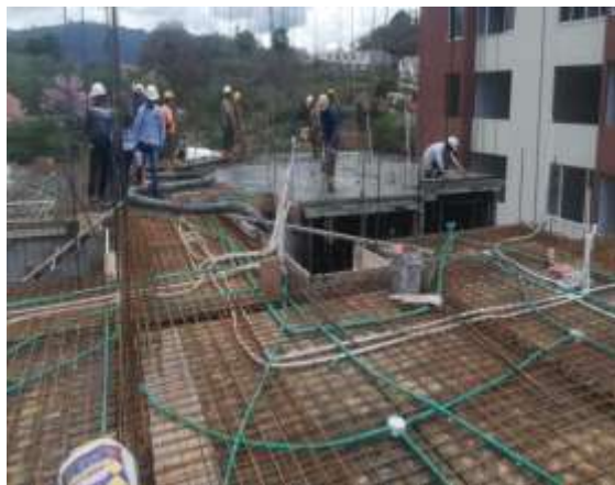
Figura 11. Vibrado del concreto en viga cimentación.
