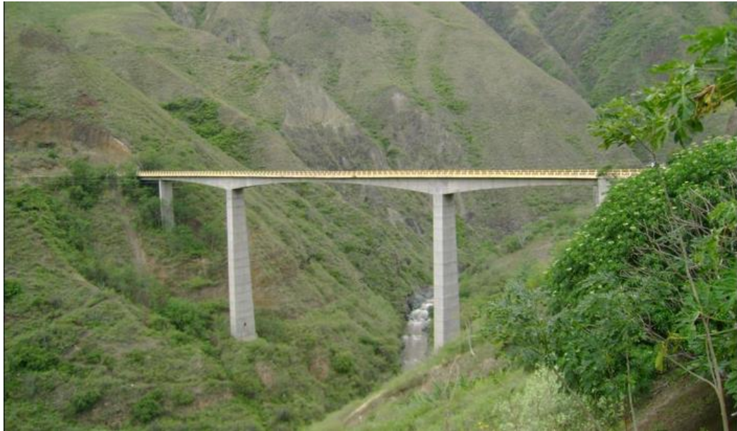
Figura 4. Puente sobre el rio Juanambu. 1976.
