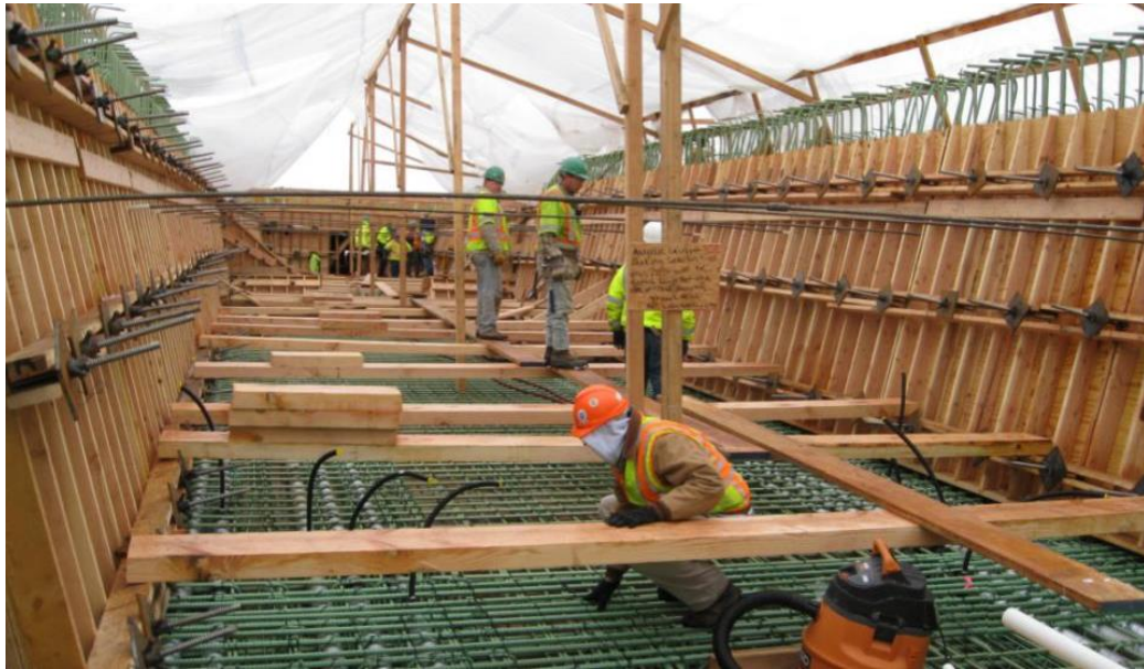
Figura 23. Método de la línea larga (long – line casting).
