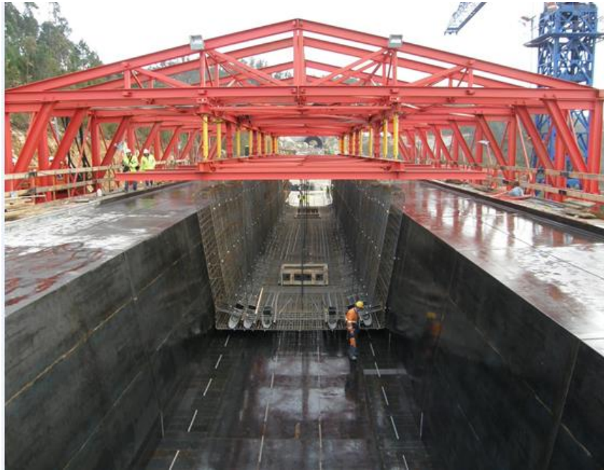
Figura 46. Alzado y colocación del acero en el parque de fabricación.
