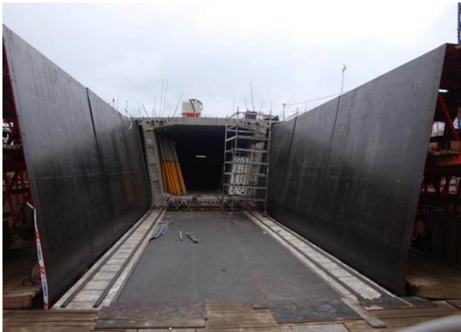
Figura 47. Empuje del tablero en el parque de fabricación.
