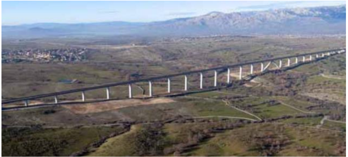
Figura 74. Viaducto Arroyo del Valle.
