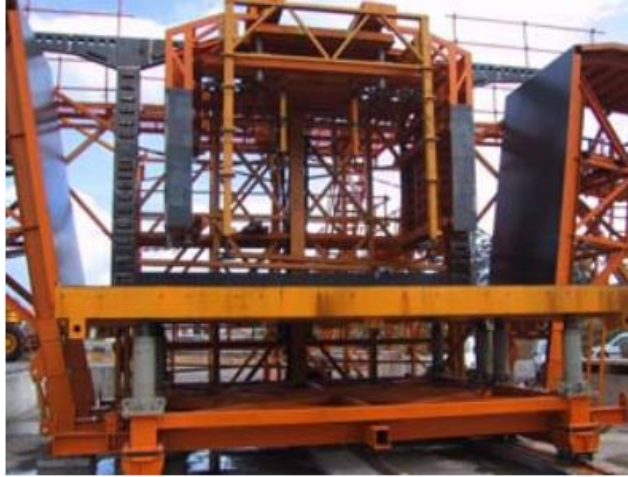
Figura 26. Encofrado inferior usado en la fabricación de dovelas prefabricadas.
