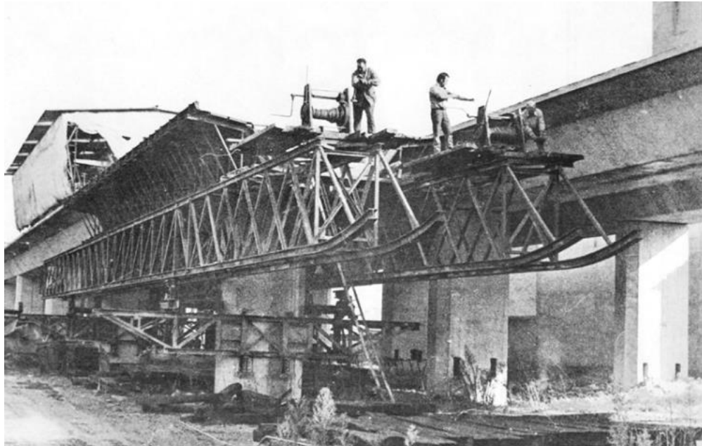
Figura 65. Puente en Gerona, España. Primer puente construido por autocimbra.
