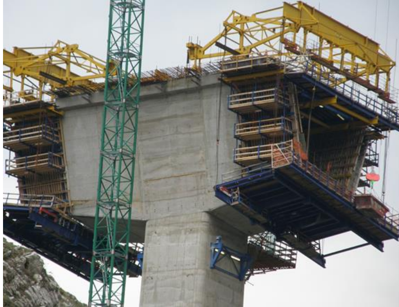
Figura 11. Colocación de dos carros de avance sobre una pila.
