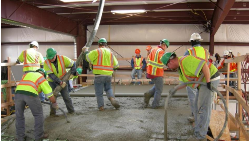
Figura 27. Hormigonado de la parte inferior de una dovela prefabricada.
