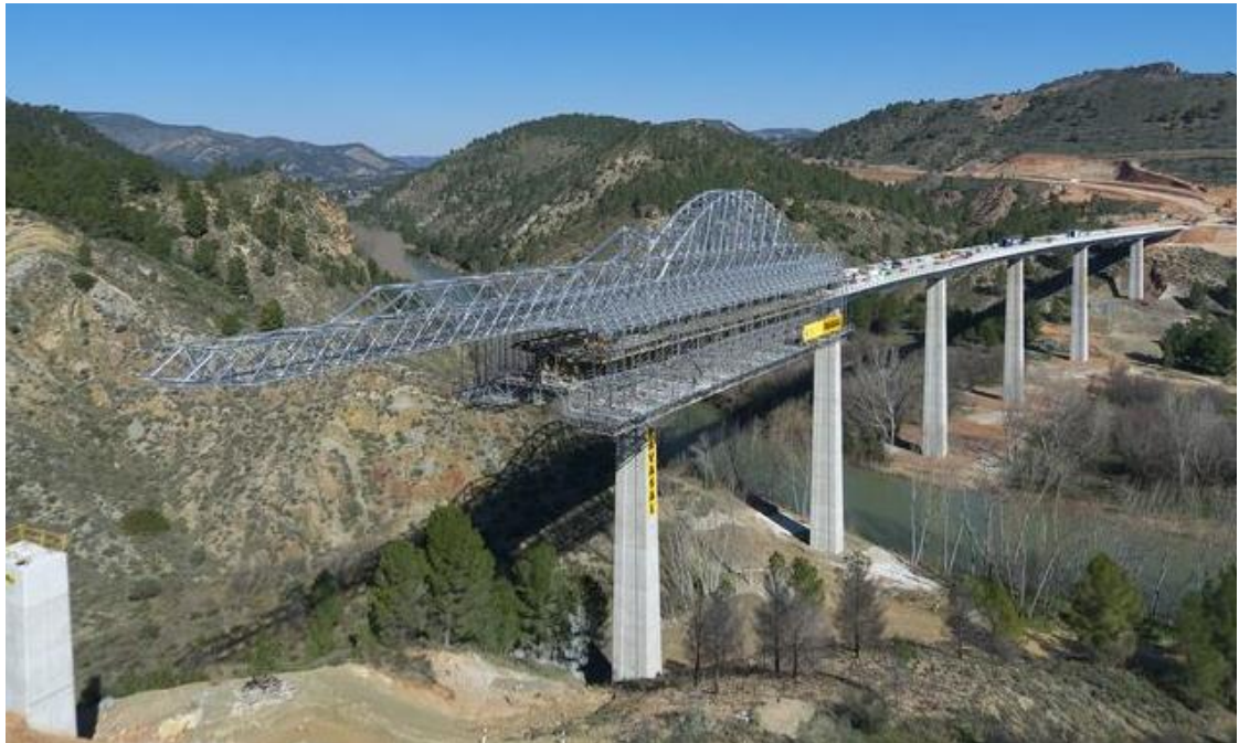
Figura 63. Viaducto Cofrentes construido por autocimbra.
