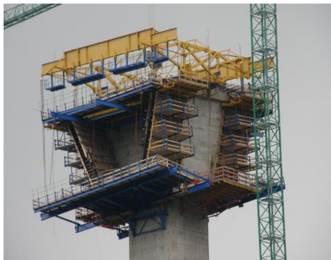
Figura 2. Hormigonado de las dovelas en doble fase.
