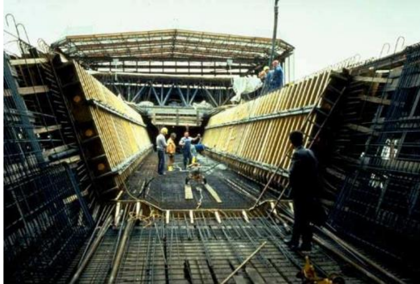
Figura 43. Parque de fabricación en puentes empujados.
