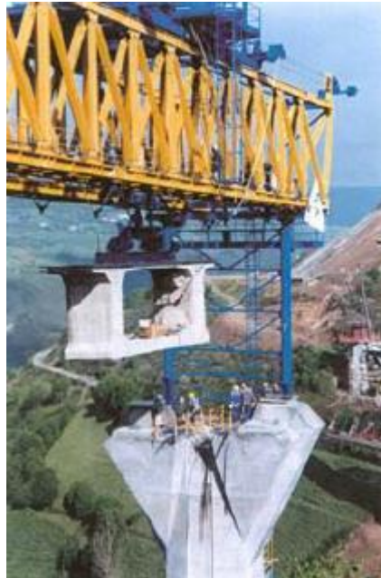
Figura 32. Viga de lanzamiento usado en el montaje de dovelas prefabricadas.
