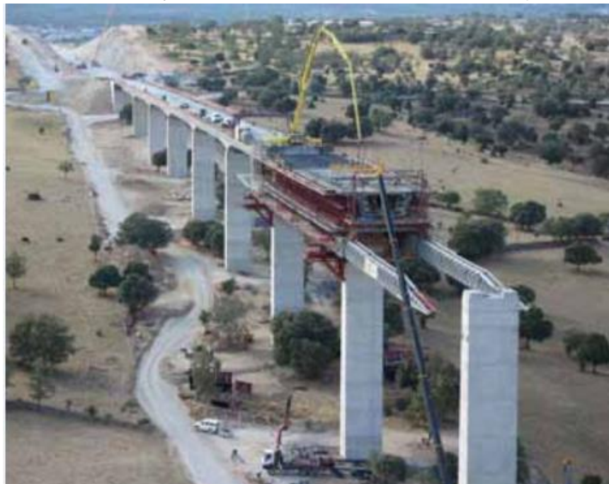
Figura 75. Viaducto Arroyo del Valle construido con cimbra autoportante.
