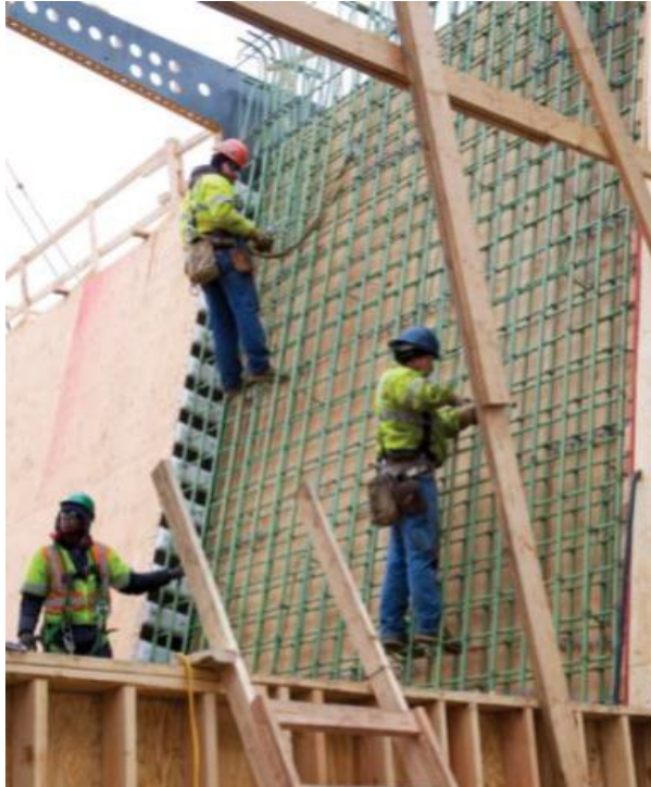
Figura 25. Colocación de refuerzo en dovelas prefabricadas.
