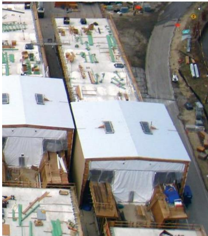
Figura 29. Curado al vapor por medio de coberturas móviles.
