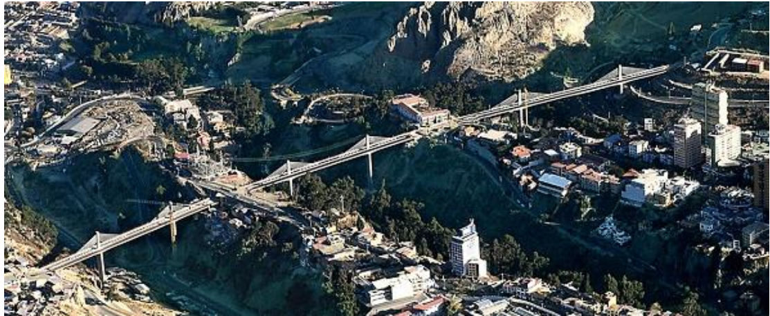
Figura 55. Puente extradosado los Trillizos inaugurado en Noviembre de 2010.
