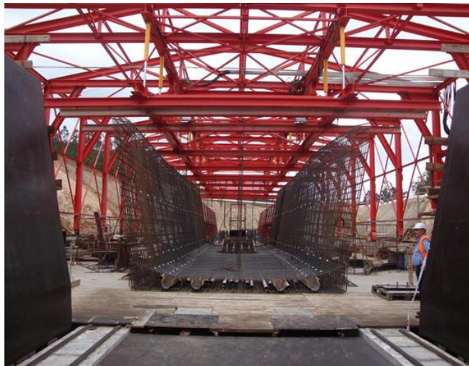
Figura 45. Montaje del acero de refuerzo.
