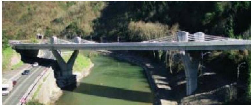
Figura 57. Puente sobre el río Deba, España.
