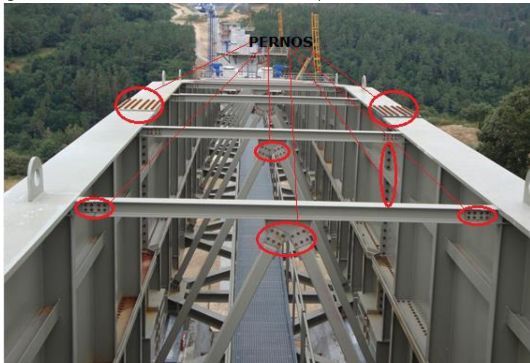
Figura 48. Pernos usados en la conexión de las partes de la nariz de lanzamiento.
