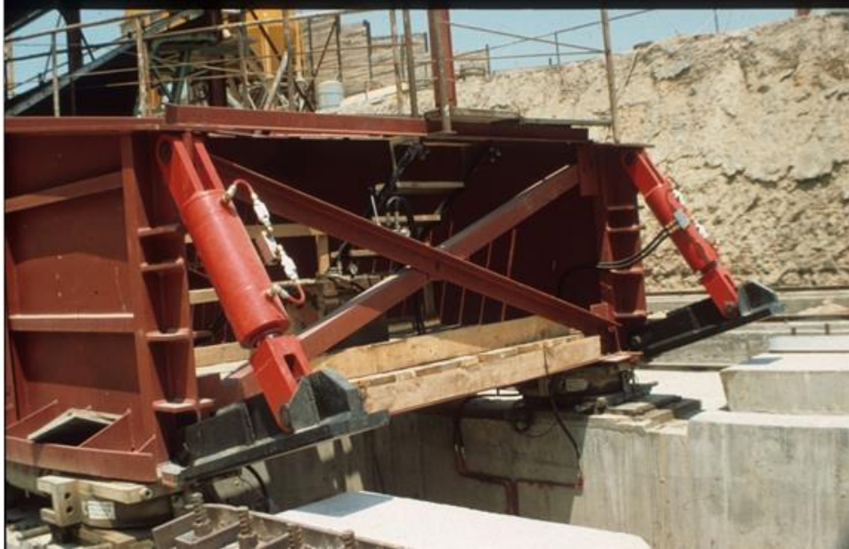
Figura 50. Gatos especiales para recuperar altura.
