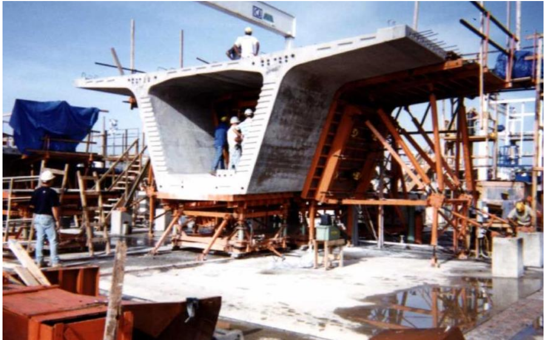
Figura 24. Método de la línea corta (short – line casting).
