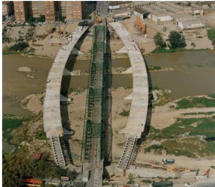
Figura 35. Construcción de puente empujado con radio de curvatura constante.
