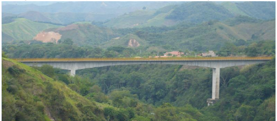
Figura 76. Puente Cajamarca de la carretera Armenia - Ibagué.
