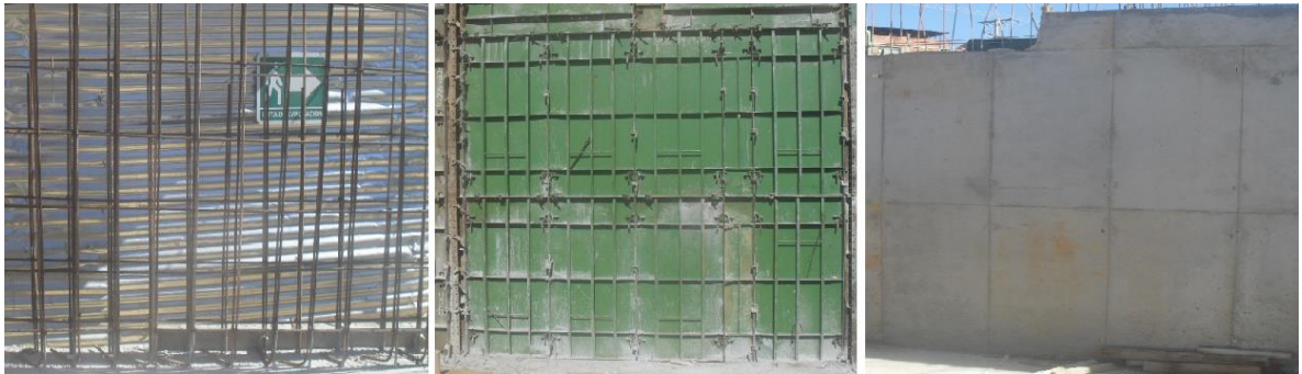
Figura 18. Construcción de un muro estructural.
