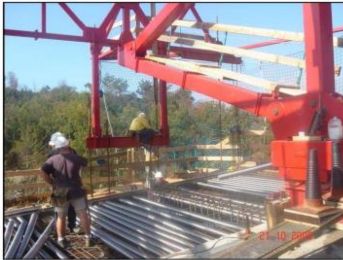
Figura 13. Colocación de las vainas de pretensado.
