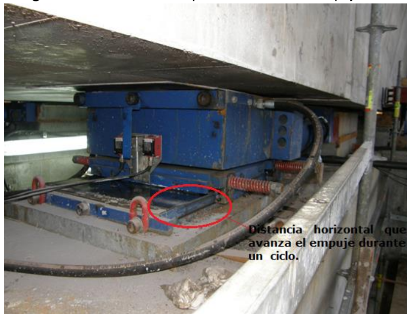
Figura 51. Gato hidráulico para el sistema de empuje.
