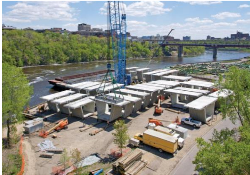
Figura 31. Almacenamiento de dovelas.
