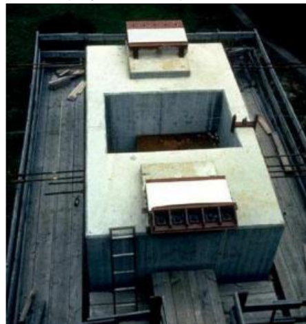
Figura 52. Apoyo de neopreno teflón.
