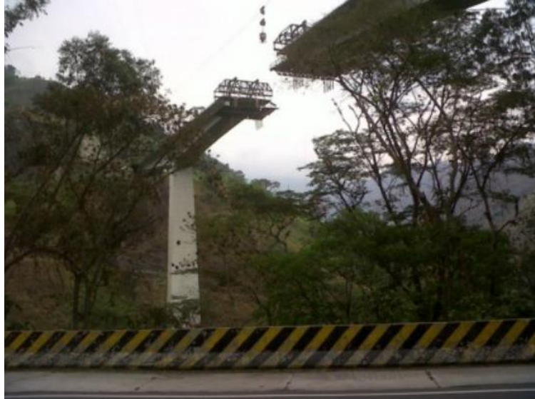
Figura 77. Puente Cajamarca construido por voladizos sucesivos “in situ”.
