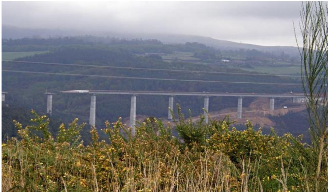
Figura 34. Viaducto Silleda, construido mediante el sistema de empuje.
