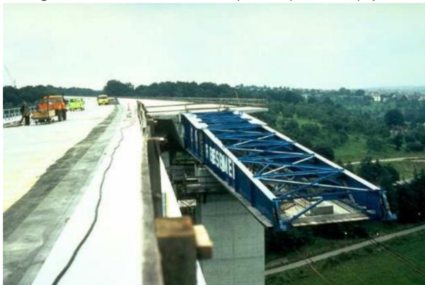
Figura 49. Nariz de lanzamiento para un puente empujado.
