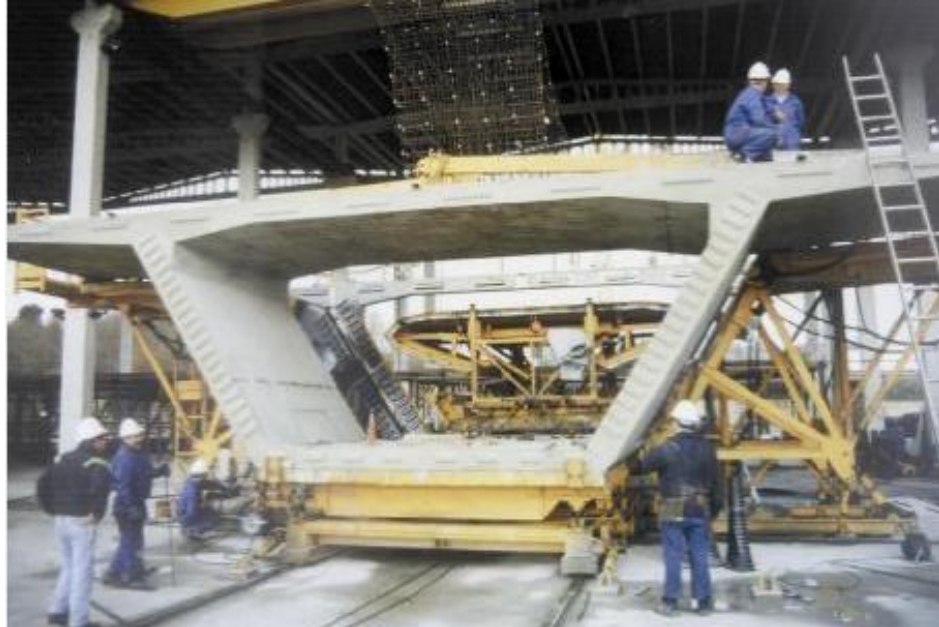
Figura 30. Retirada de la dovela conjugada.
