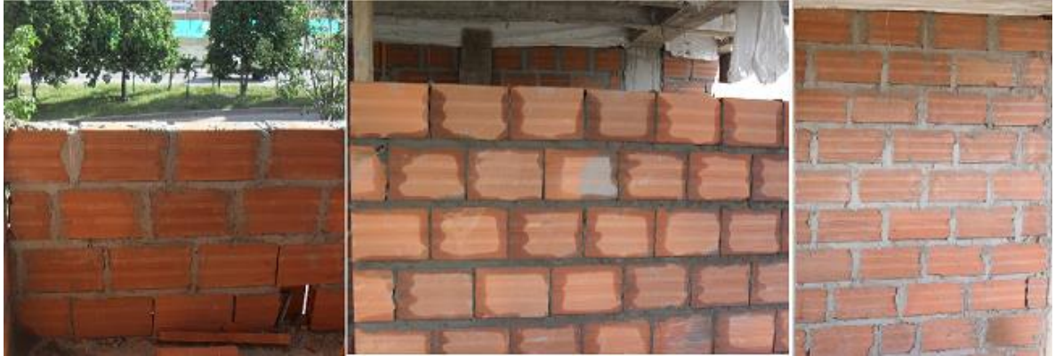
Figura 17. Construcción de un muro de mampostería.
