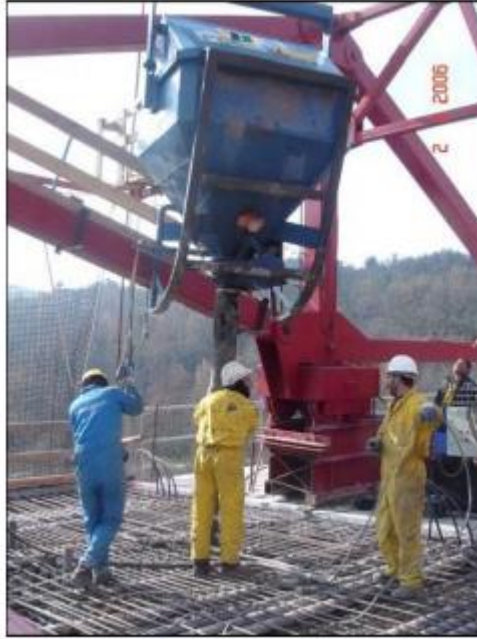
Figura 14. Hormigonado de la losa superior de la dovela.
