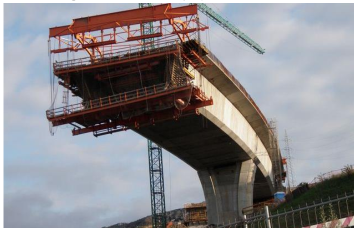
Figura 12. Avance y fijación del carro.
