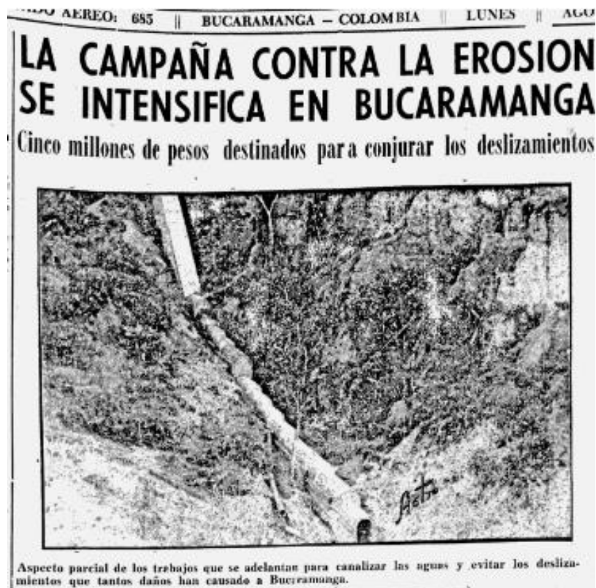
Figura 12: Trabajos de canalización (V,L. 20-07-1956. P.1)
