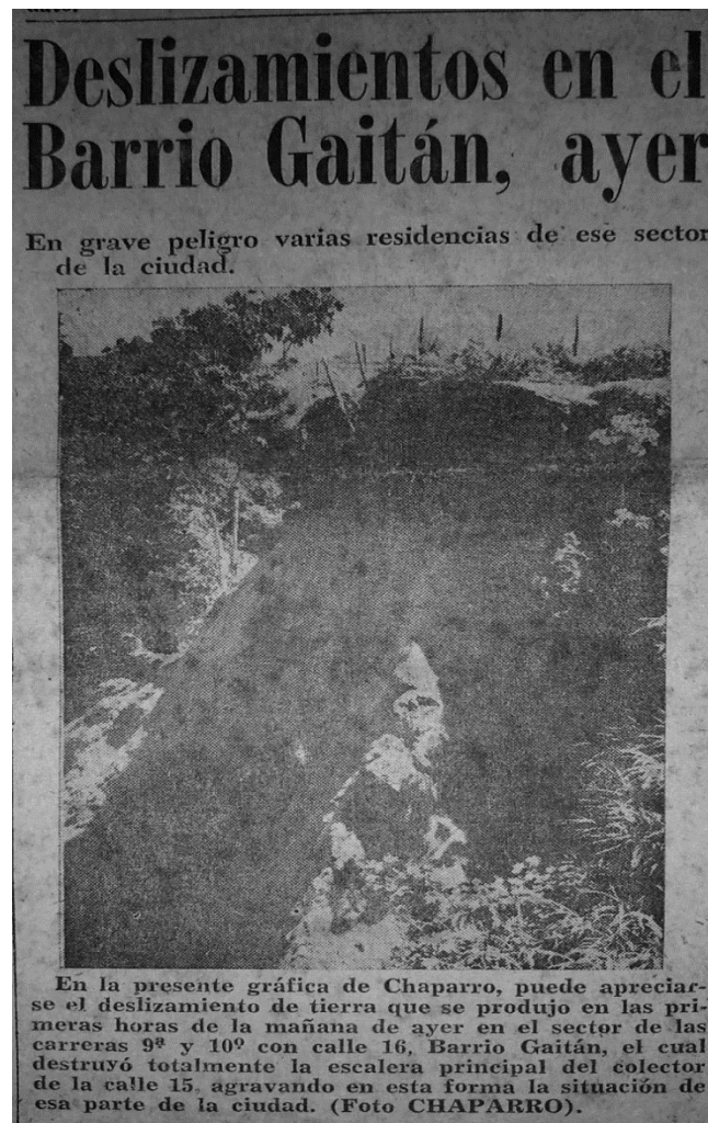
Figura 36: Fotografía de (Chaparro) movimiento en masa y destrucción de la escalera principal de un colector en barrio Gaitán. (V.L, 01-10-1961, P.2)
