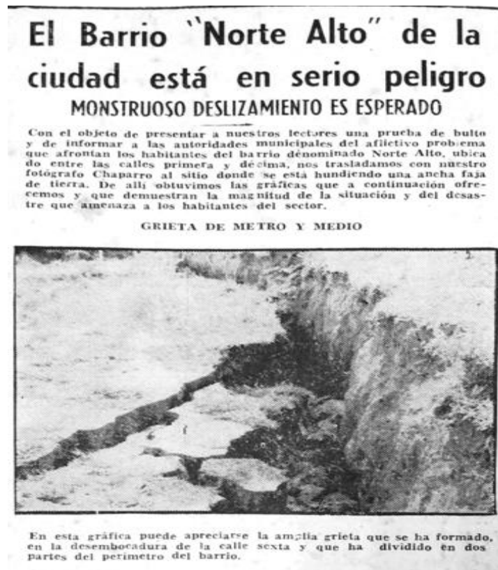
Figura 10: Grieta formada por la erosión en el barrio Norte Alto (V,L. 30-06-1954, P.2).
