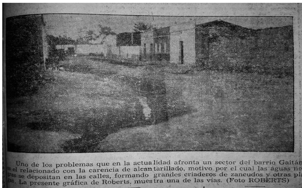
Figura 27: Fotografía de (Roberts), falta del alcantarillado en barrio Gaitán (V.L, 16-02-1961, P.5).
