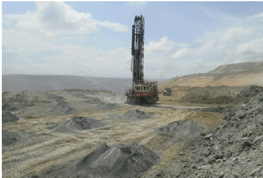
Figura 12. Área de perforación para Voladura.
