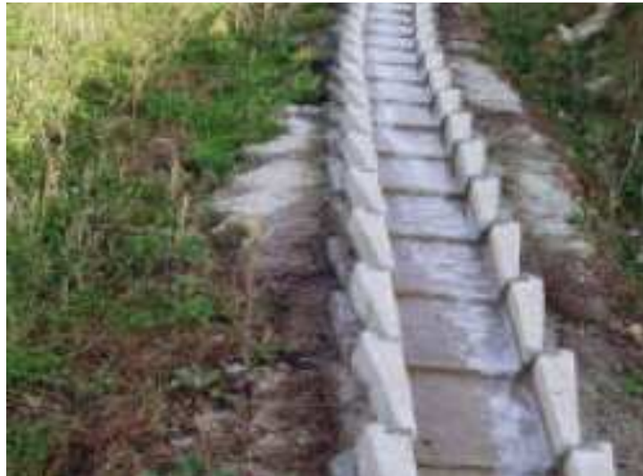
Fotografía No. 15 Cascada de aireación propuesta
