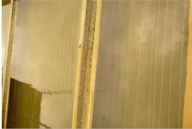
Fotografía No. 11 Sistema de Sedimentación tipo laminar
