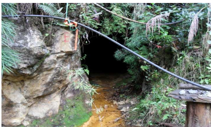
Fotografía No. 3 . Drenaje ácido de mina, color rojizo
