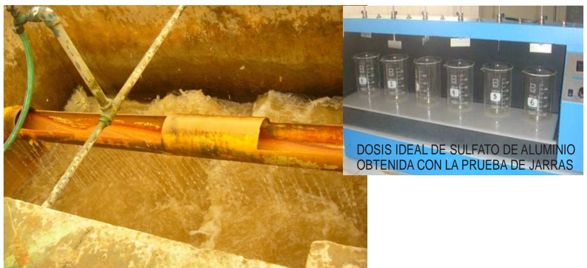
Fotografía 9 Turbulencia generada por un Retro mezclador Hidráulico.
