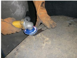
Pulido detalles internos con mototool
