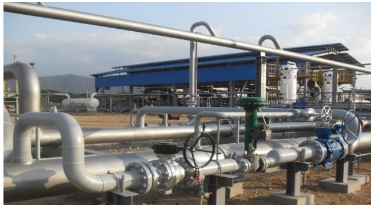
Figura 14. Válvula de recirculación.
