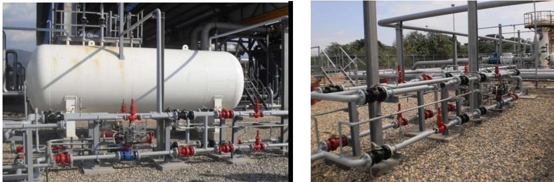
Figura 20. Sistema de gas combustible y arranque.
