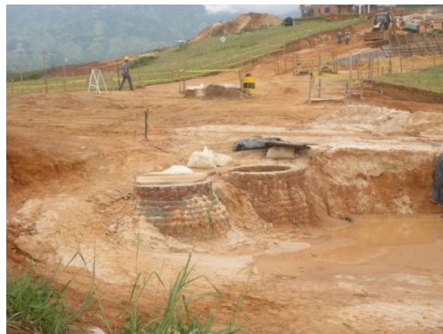
Figura 5: Pozo de Inspección
