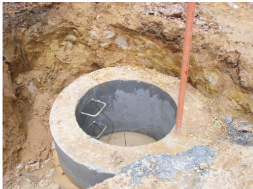
FIGURA 4: Base Pozo de Inspección
