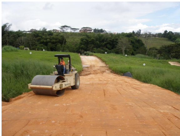
FIGURA 6: Compactación subrasante Vía
