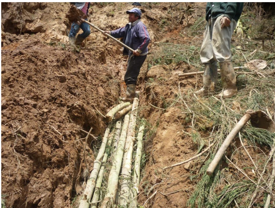
Foto 40. Construcción de filtro vivo en madera rolliza.
