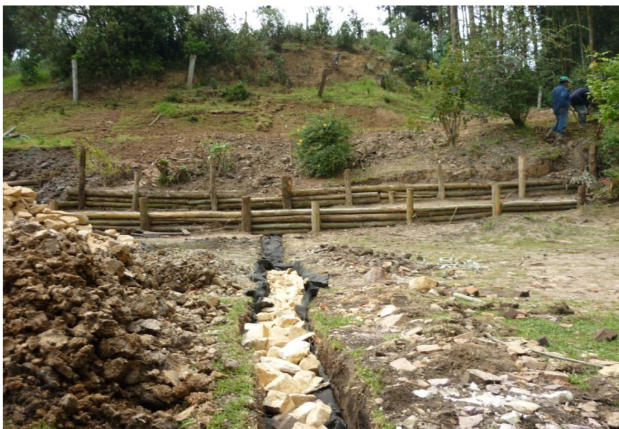
Foto 49. Construcción de filtro en piedra media songa y geotextil.
