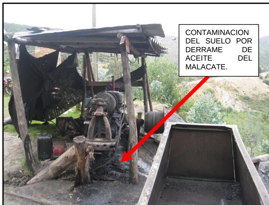
Foto 54. Malacate rudimentario con fuga de aceites contaminando suelo y agua de escorrentía.
