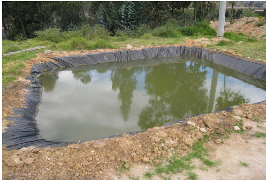
Foto 14. Manejo inadecuado de almacenamiento de aguas contaminadas y no hay ningún tratamiento, ni aireación de esta.
