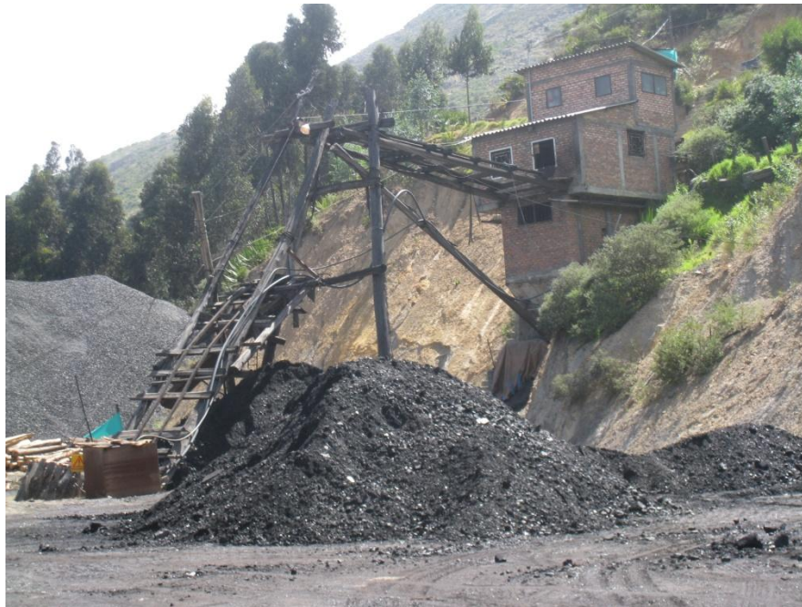
Foto 60. Patio de acopio de carbón con fallas en el almacenamiento y mitigación de impactos, sin control de aguas de escorrentía.
