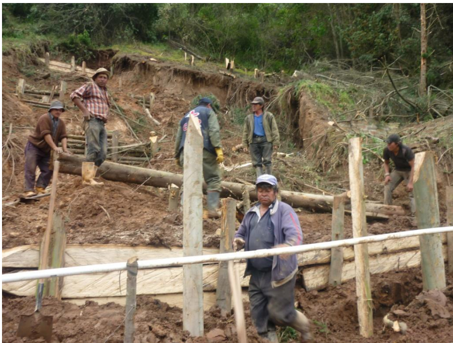
Foto 44. Estabilización de zona de deslizamiento.
