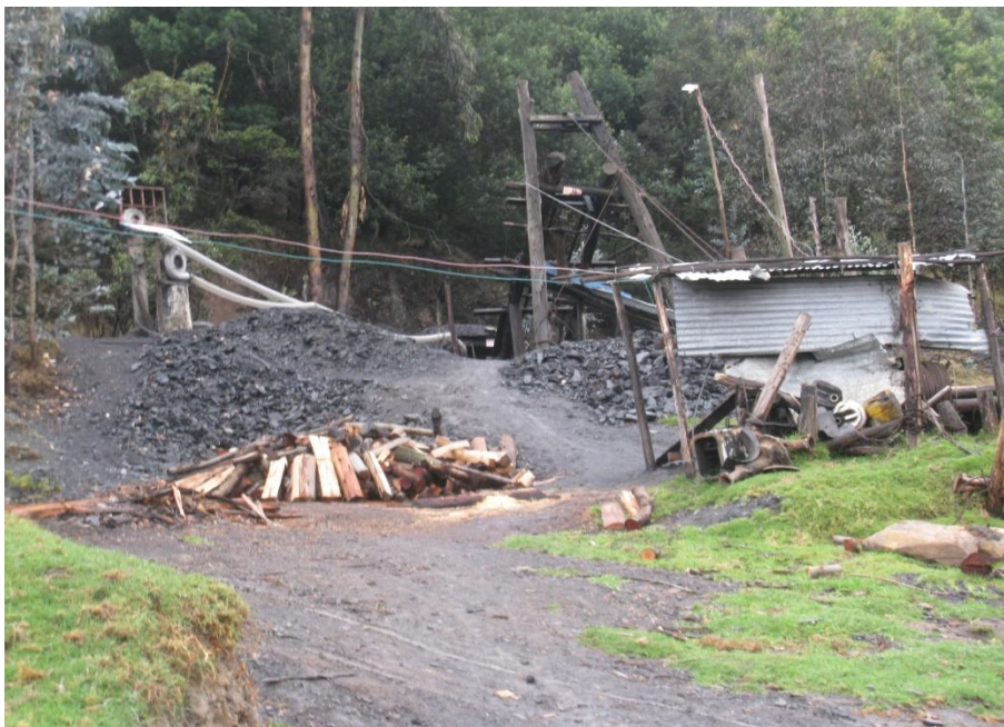
Foto 28. Desorden en las actividades mineras de superficie.
