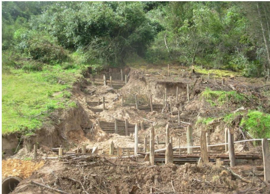
Foto 37. Construcción de trincho en madera de la zona.
