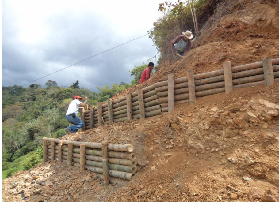
Foto 36. Fase de perfilado y conformación de la parte posterior del trincho.
