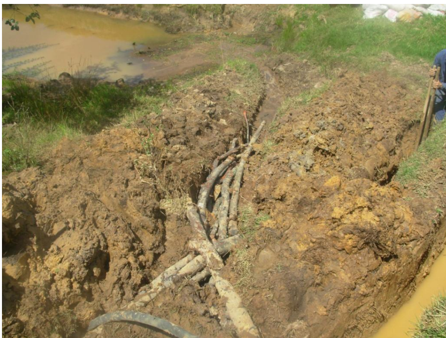
Foto 41. Construcción de filtro vivo en madera perpendicular a la pendiente del terreno.
