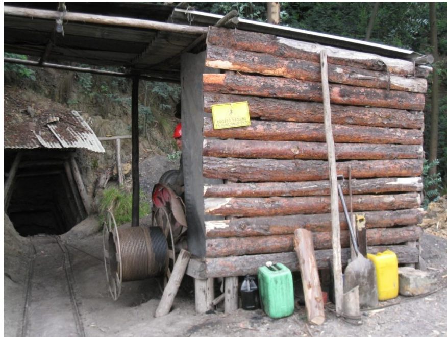
Foto 65. Infraestructura inadecuada para el cuarto del maquinas malacate diesel generando contaminación por ruido.
