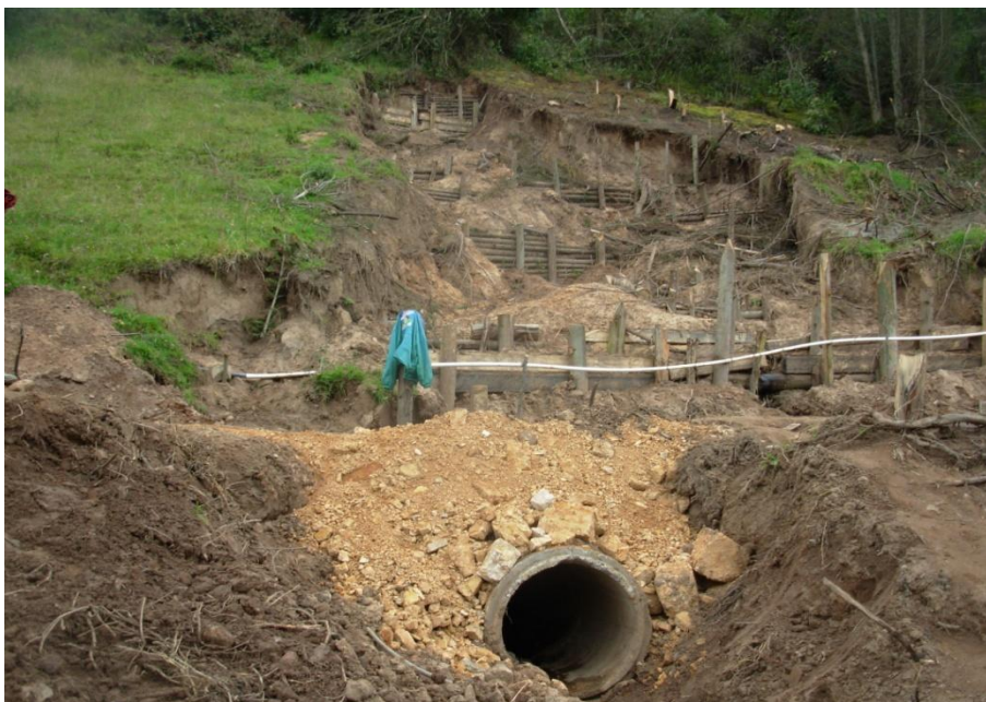
Foto 48. Conformación de control de deslizamiento, drenaje y erosión con filtros vivos, trinchos y canalización de aguas con alcantarilla de concreto.
