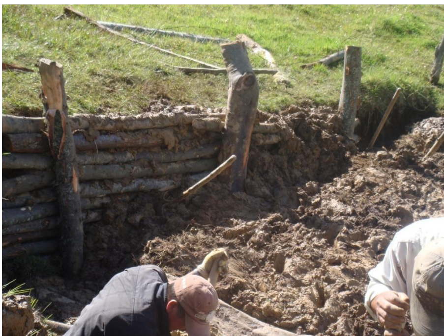
Foto 39. Construcción de trincho en madera rolliza.
