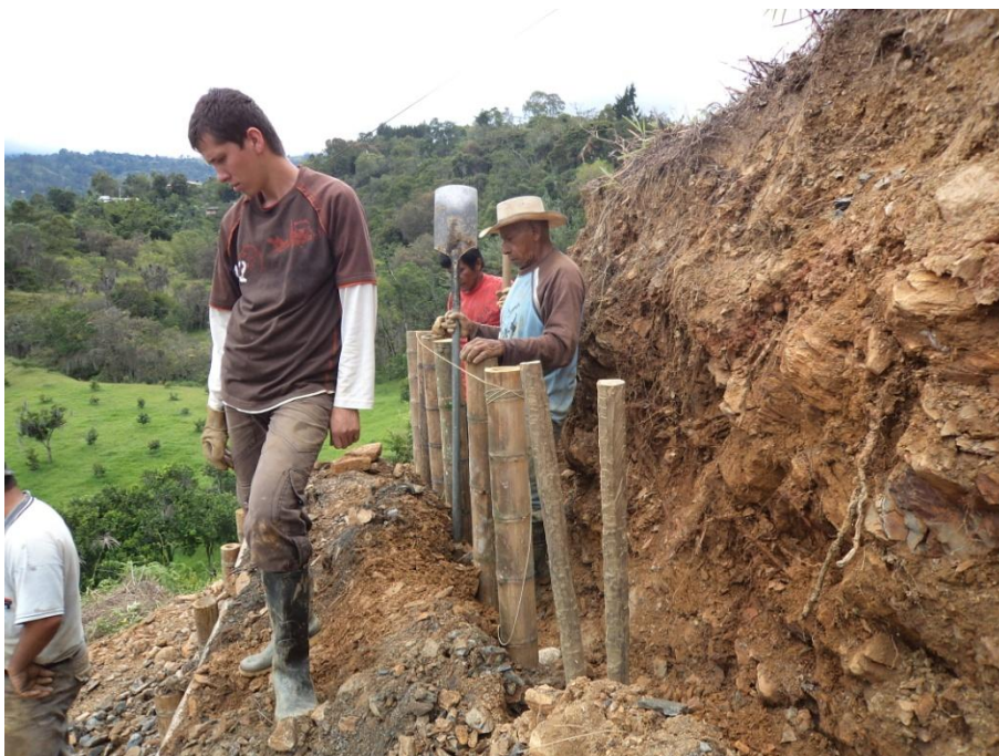
Foto 35. Fase de hoyado e hincado de portería.
