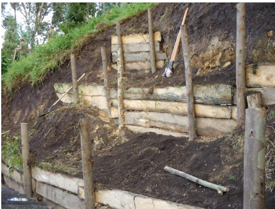
Foto 47. Sistema de trincho en madera y orillo en terrenos con deslizamiento.
