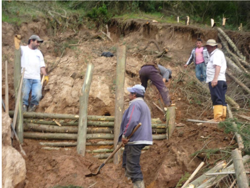
Foto 42. Construcción de trincho en madera para control de erosión y deslizamiento.
