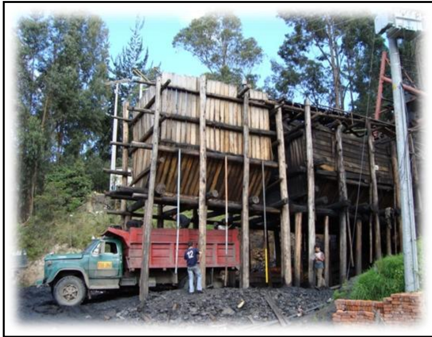
Foto 9. Construcción de tolvas en madera para el almacenamiento de carbón y sistema de cargue por gravedad para pequeña minería.
