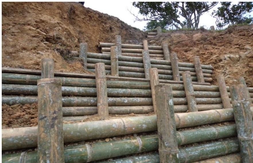
Foto 32. Construcción de trincho en guadua para control de erosión.
