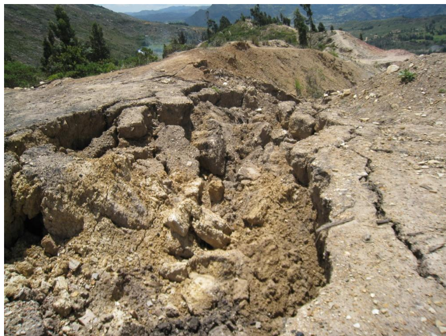
Foto 25. Área de subsidencia por mala planificación minera.
