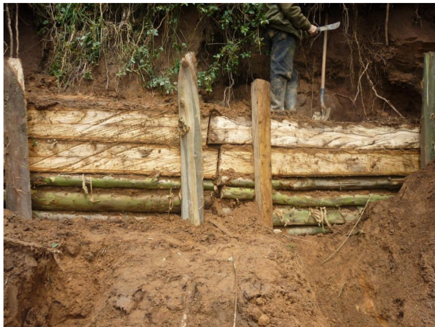
Foto 43. Construcción de trincho en madera para contención de erosión de talud
