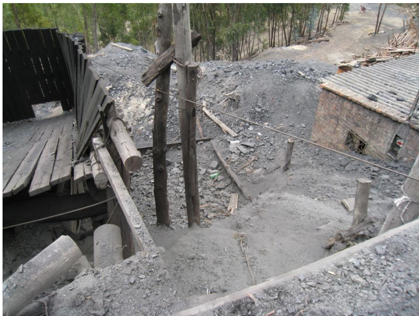
Foto 30. Deficiente disposición de estériles de la explotación.
