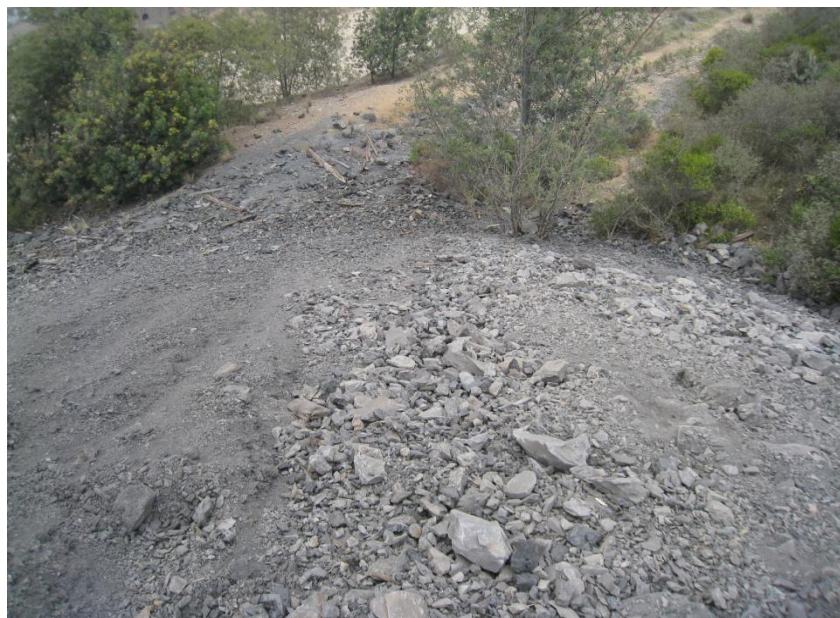
Foto 21. Deficiente disposición de estériles en terrenos con altas pendientes generando destrucción capa vegetal.
