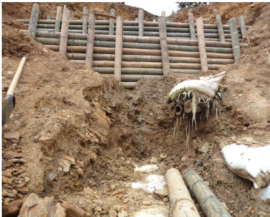
Foto 33. Construcción de trincho en guadua en terreno de alta pendiente con su drenaje.
