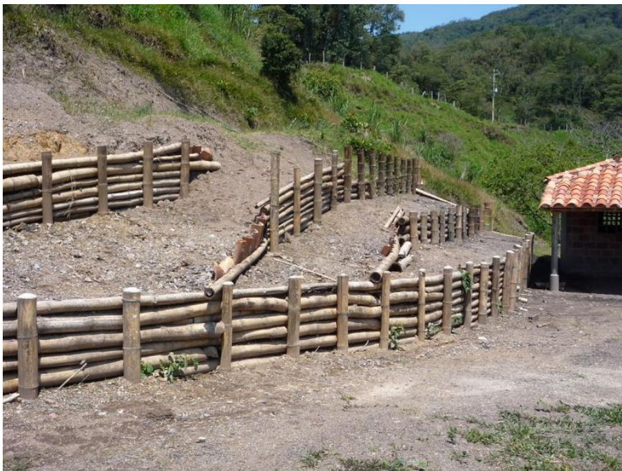
Foto 38. Resultado parcial de trincho en guadua pero falta reforestación.
