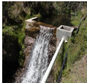
Figura 6. Punto adicional de suministro al tanque de D=2''
