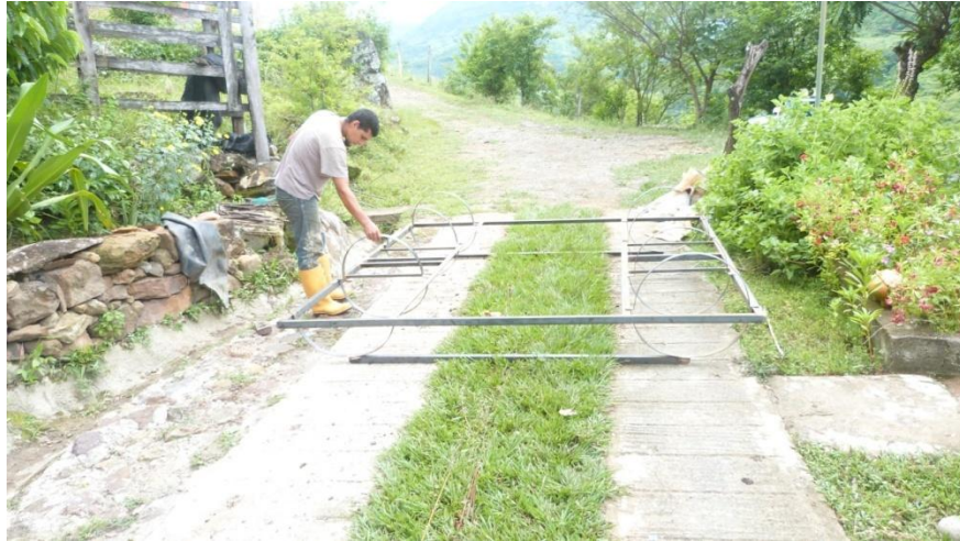
Figura 32. Estructura de prueba (soporte bomba)
