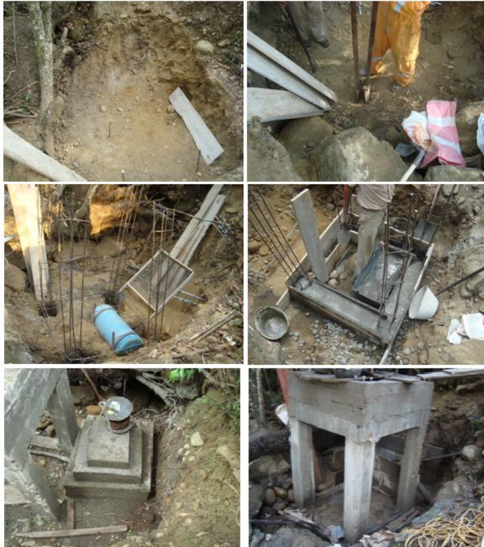
Figura 37. Seguimiento de la estructura concreto y contrapeso parte A
