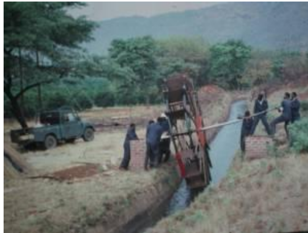
Figura 11. Instalación bomba de rueda de Mazowe.
