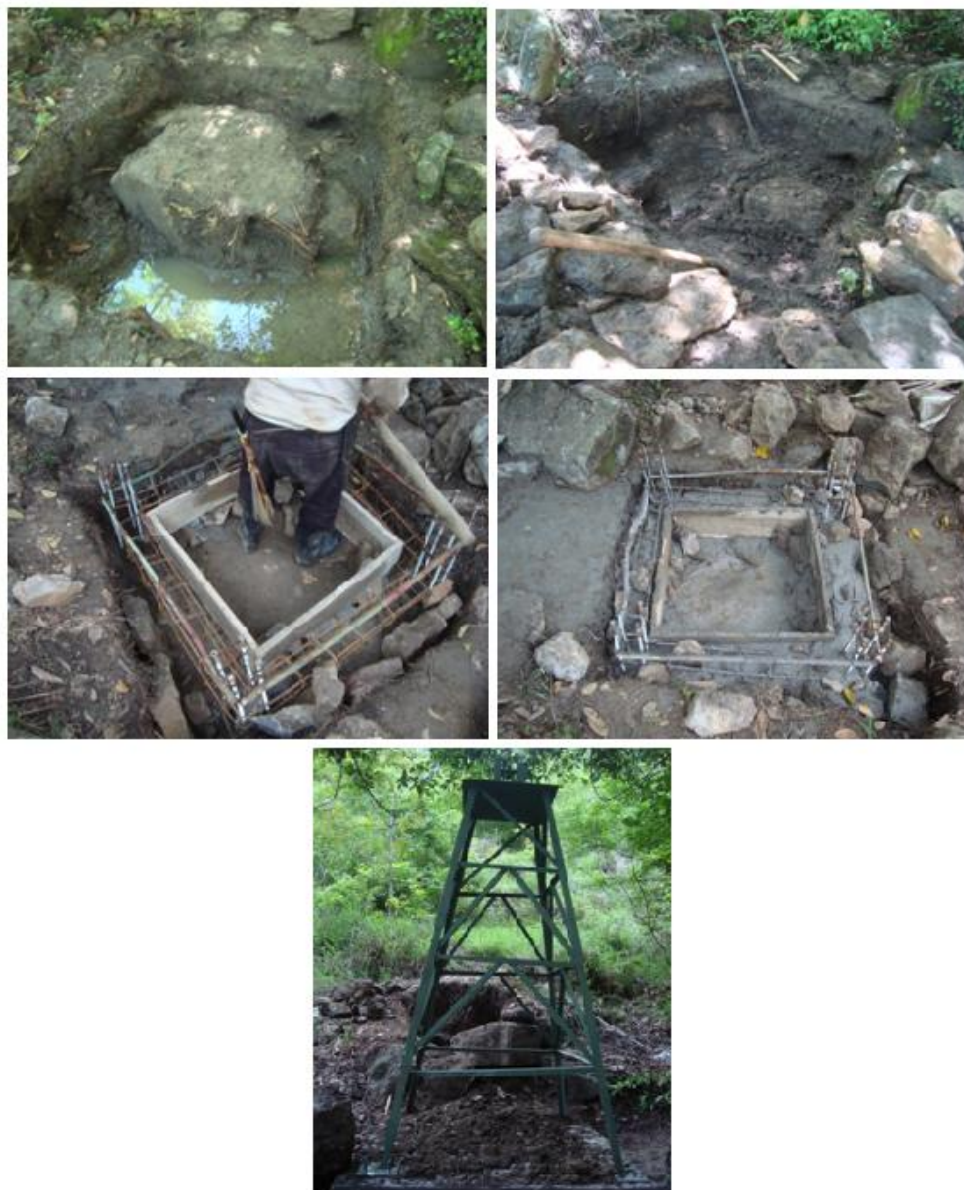
Figura 38. Seguimiento de la estructura concreto y contrapeso parte B
