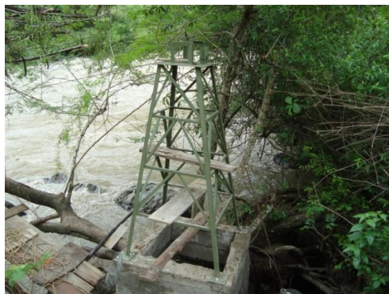
Figura 41. Torre A sobre estructura concreto
