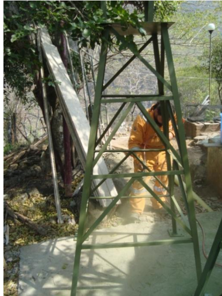
Figura 40. Aplicación de pintura anticorrosiva en la torre
