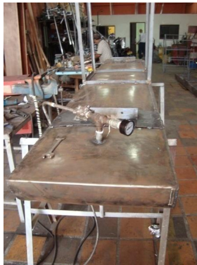
Figura 53. Instalación de equipos para prueba neumática
