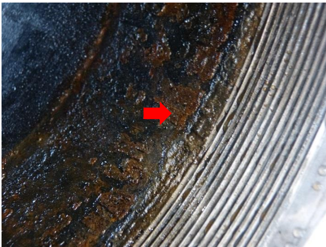
Figura 52 Housing extremo superior. Alta pérdida de material por corrosión en el interior.
