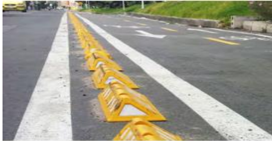
Figura 27. Ejemplo de elementos de segregación discontinuos y de baja altura (Bogotá).
