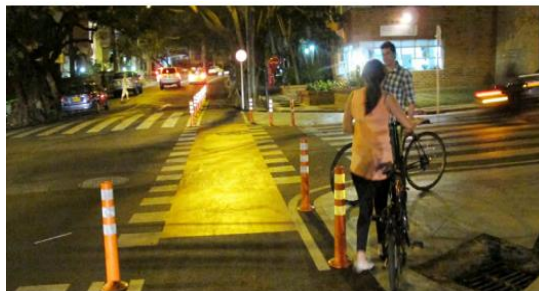
Figura 20. Solución de paso para ciclistas en una intersección con el refuerzo cromático de la zona de cruce (Medellín)
