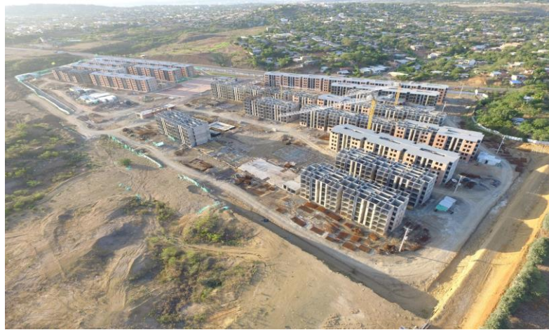
Constructora Bolivar, anillo vial occidental, 1040 unidades de vivienda.
