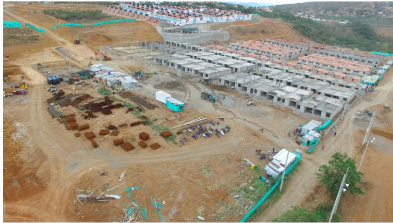
Constructora Monape, Punta Gaviota, 300 unidades de vivienda.
