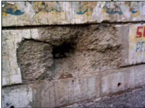
Figura 4. Fracturamiento del concreto y pérdida de la sección por impacto de (a) un objeto, (b) una maquina retroexcavadora.
