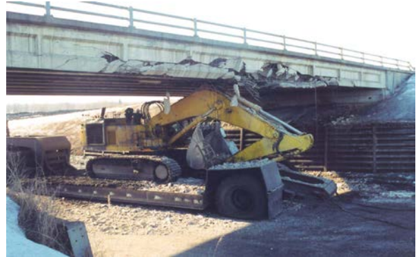
Figura 4. Fracturamiento del concreto y pérdida de la sección por impacto de (a) un objeto, (b) una maquina retroexcavadora.
