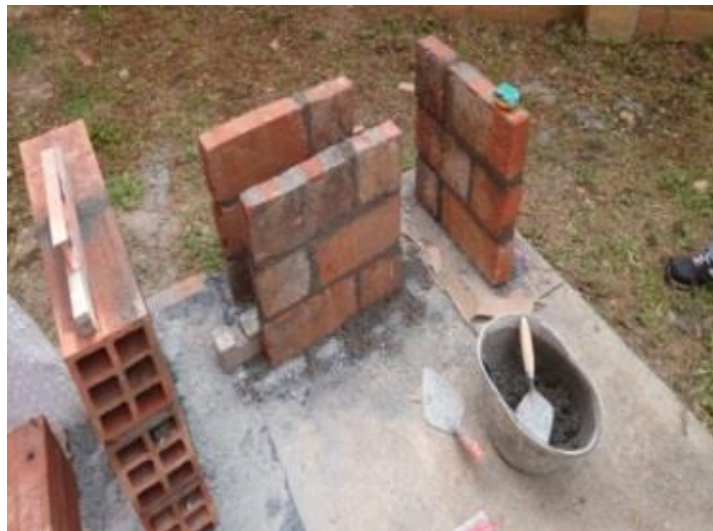
Figura 8. Muros de mampostería
