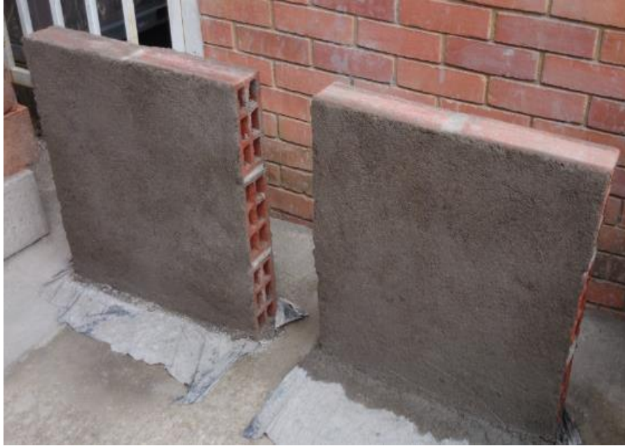
Figura 9. Frisado de muros
