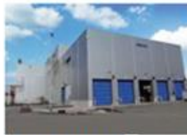
PLANTA SARPSBORG 2 UBICACION : NORWICH OPERACION : 2010 CAPACIDAD : 78000 TONELADAS/AÑO PRODUCCION DE ENERGIA : 256 GWh termico/año
