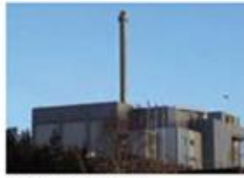
PLANTA HURUM UBICACION : NORWICH OPERACION : 2001 CAPACIDAD : 39000 TONELADAS/AÑO PRODUCCION DE ENERGIA : 105 GWh termico/año
