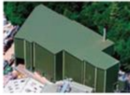
PLANTA ISLA DE WIGHT UBICACION: REINO UNIDO OPERACION : 2009 CAPACIDAD : 30000 TONELADAS/AÑO PRODUCCION DE ENERGIA : (eléctrica) 1,8 MW
