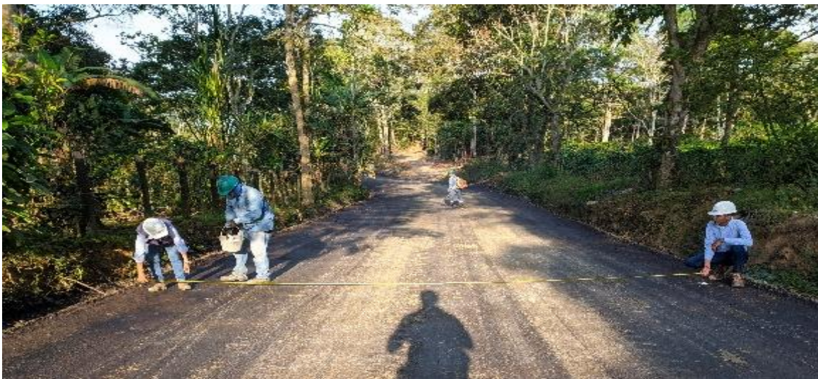
Demarcación del eje y bordes de la vía con cal
