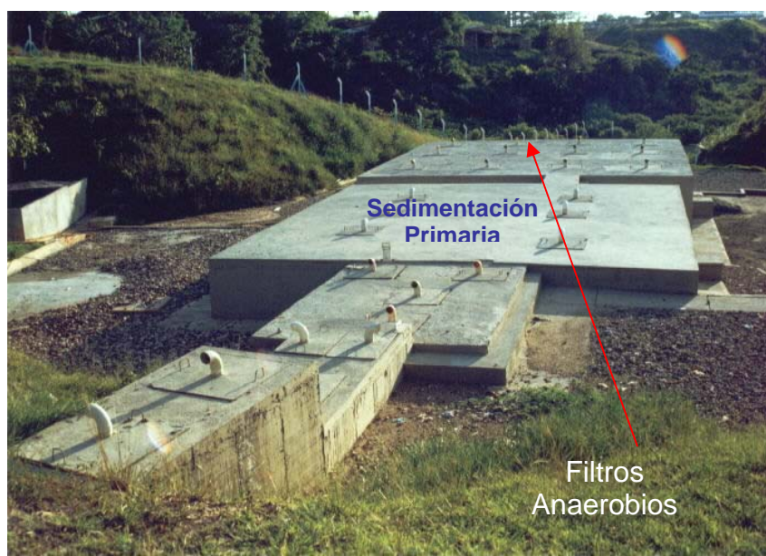
FOTO 10. PANORAMICA PLANTA BARRIO BOSTON
