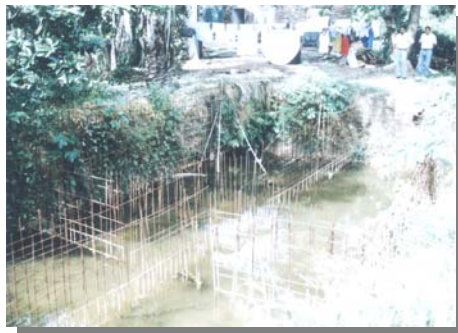
FOTO 8 PLANTA SIN TERMINAR.
