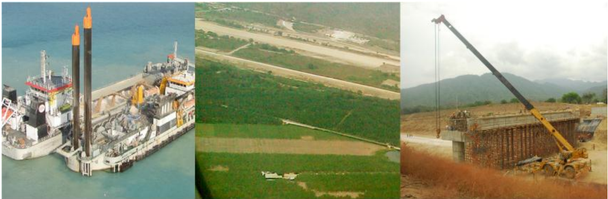
Figura 3. Infraestructura de puerto Nuevo
