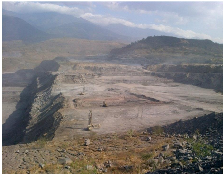
Figura 7. Área perforación para realizar una voladura
