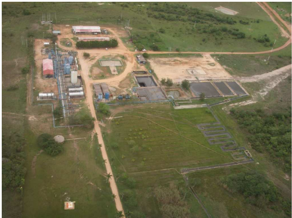
Figura 5: Vista panorámica de la estación SAD
