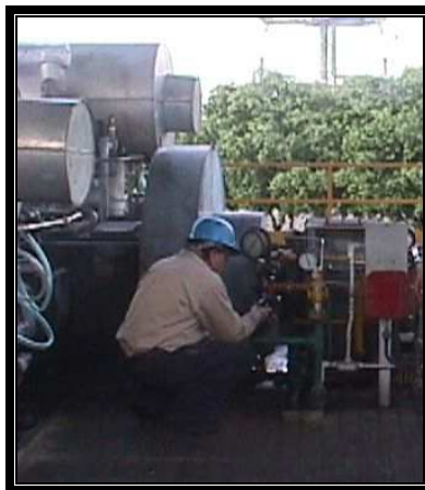
Figura 4. Limpieza de la boquilla de descarga
