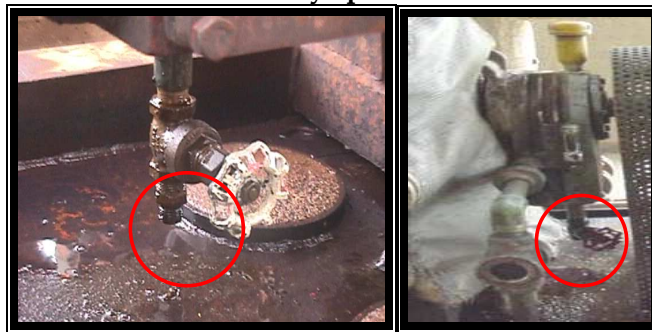
Figura 1. a) Drenaje cerca de la plataforma, b) Válvula en posición de difícil acceso y apertura.
