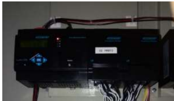
Figura A1. AcuRev con dos módulos instalados.
