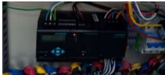
Figura A2. AcuRev con un módulo instalado.
