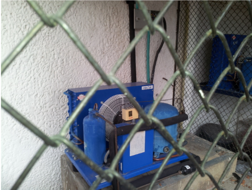
Figura 6.2: Bobinas expuestas al polvo en Bienestar Universitario Fuente: Autores
