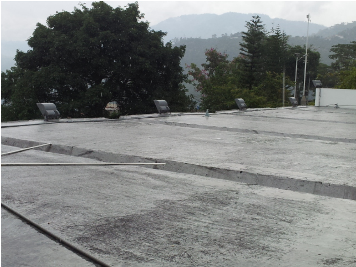
Figura 6.1: Techo de Bienestar Universitario Fuente: Autores
