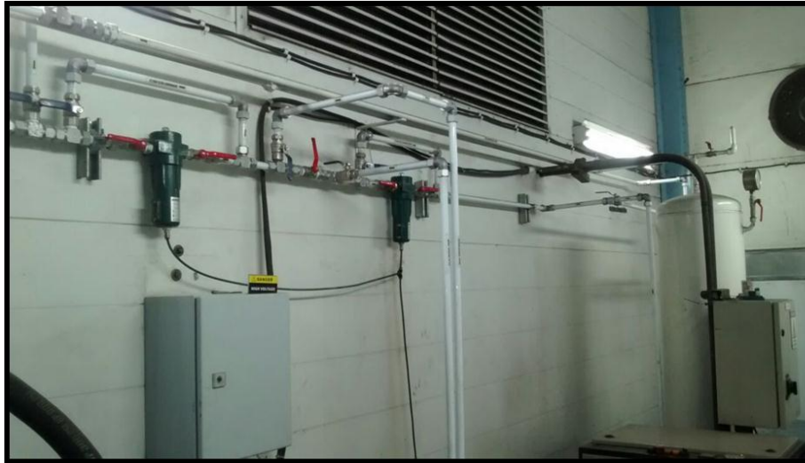
Figura 5. Red de suministro de aire de instrumentos.
