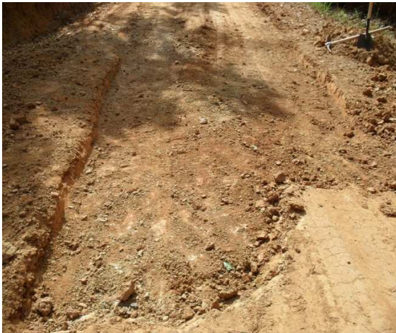
FOTO No 3: Espesor de la excavación = 15 cm
