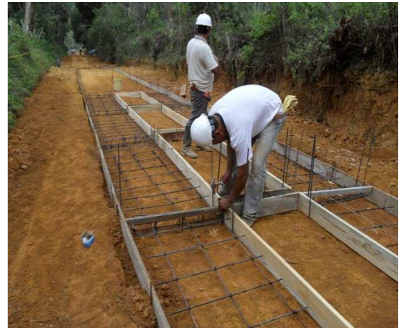
FOTO No 2: Colocación del acero
