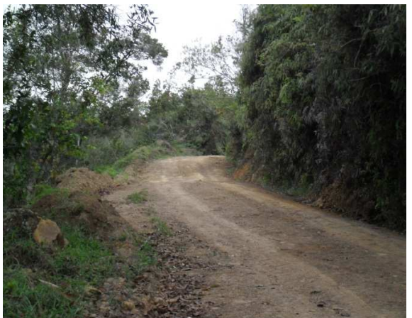
Tramo K1+900 Sector Pelicano
