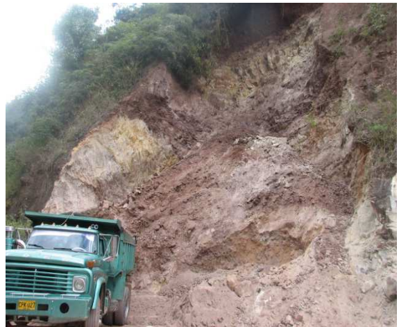
FOTO No 2: Extracción de material
