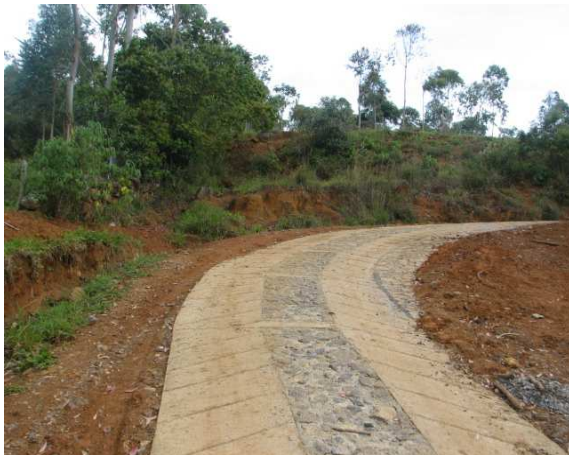
Tramo K0+250 Sector Mirador
