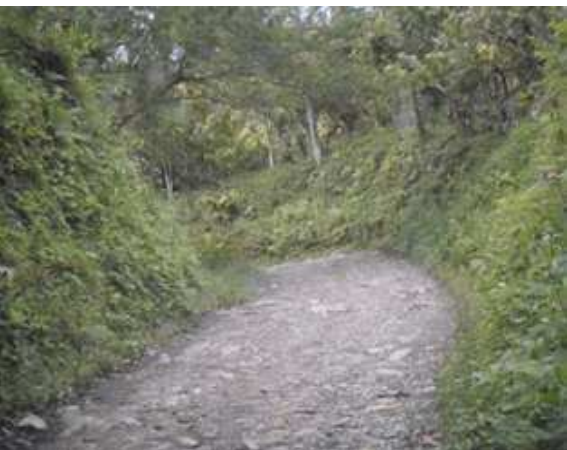
Tramo K3+370 Vía Plazuela Miradores
