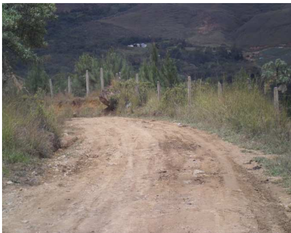
Tramo K0+500 Vía Piedra Blanca
