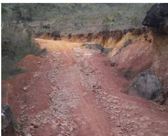
Tramo K3+900 Vía Piedra Blanca
