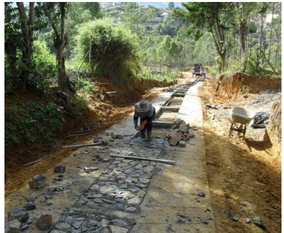
FOTO No 2: Colocación de la piedra
