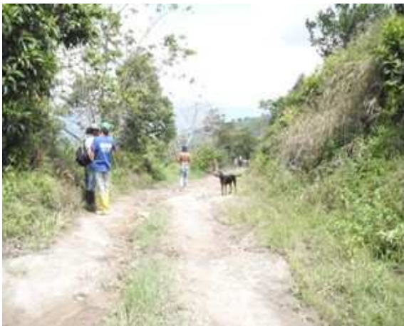
Tramo K2+900 Vía Plazuela Miradores
