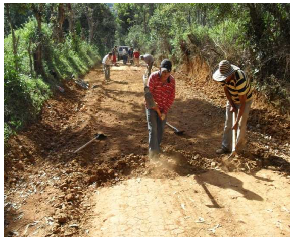
FOTO No 2: Excavación manual
