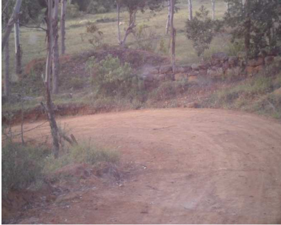
Tramo K0+250 Sector Mirador
