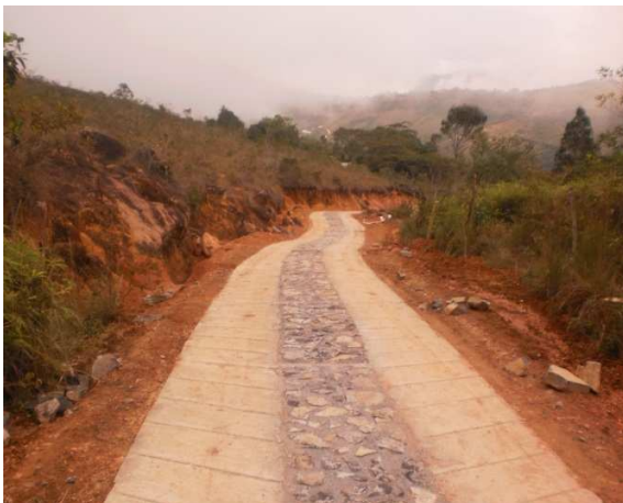
Tramo K3+900 Vía Piedra Blanca
