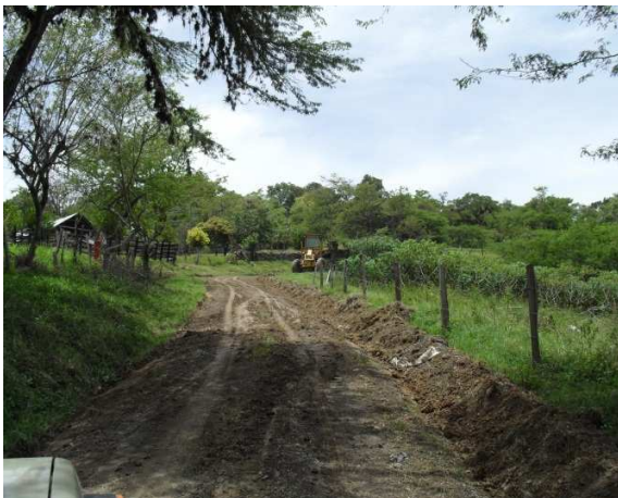
Tramo Zapatoaca – La Fuente
