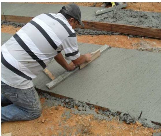
FOTO No 3: Acabado tipo espina de pescado
