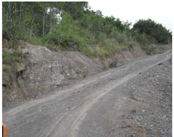
Tramo K0+750 Sector Pelicano
