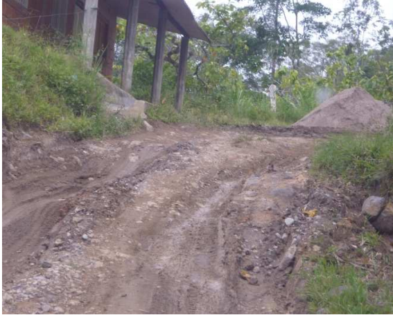
Tramo K1+400 Vía Plazuela - Miradores
