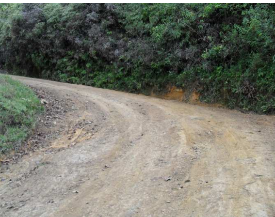
Tramo K1+400 Sector Pelicano
