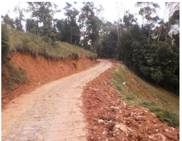
Tramo K7+100 Vía Piedra Blanca
