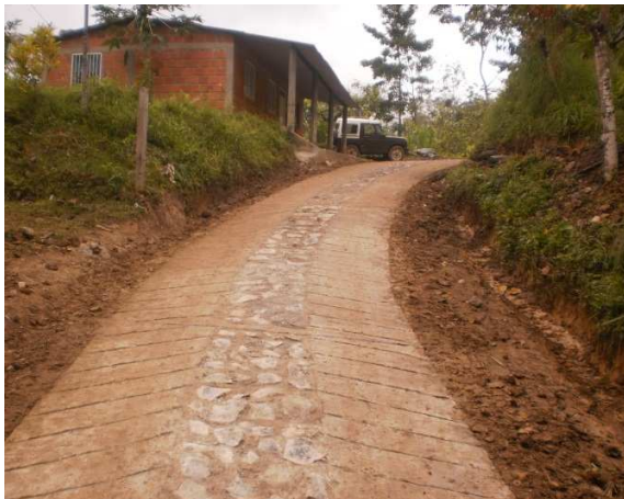
Tramo K1+400 Vía Plazuela - Miradores
