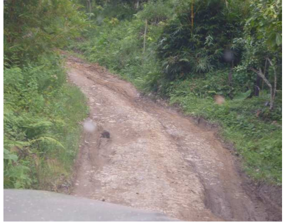
Tramo K1+590 Vía Plazuela - Miradores
