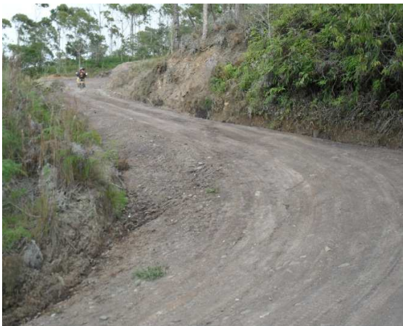
Tramo K0+500 Sector Pelicano
