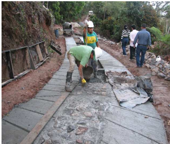
FOTO No 1: Extensión del concreto
