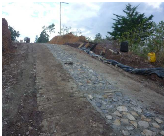
Tramo K0+750 Sector Pelicano
