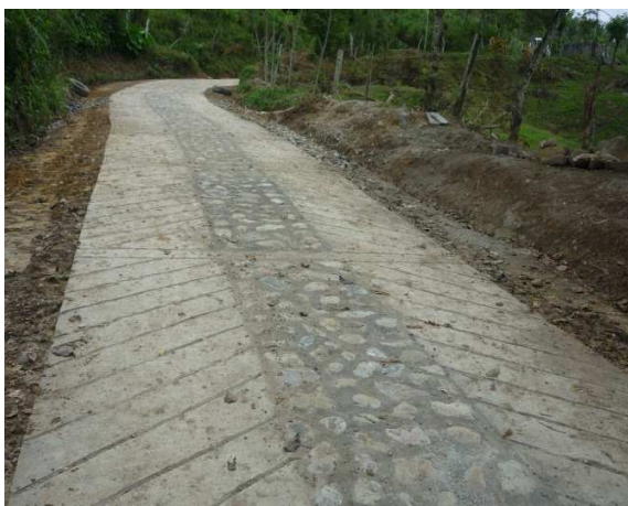
Tramo K2+900 Vía Plazuela Miradores
