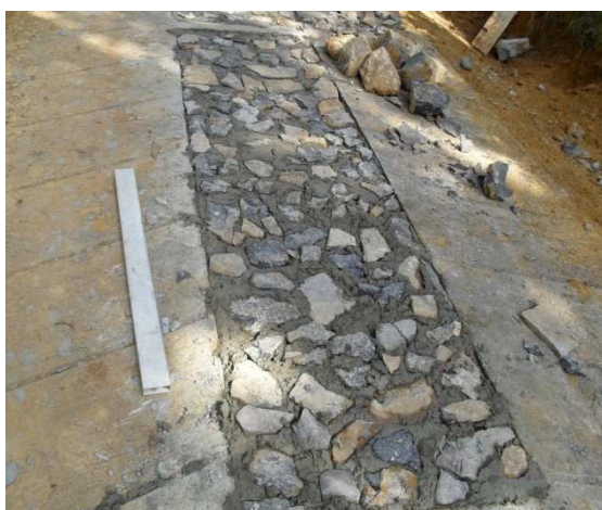
FOTO No 3: Acabado final de la piedra
