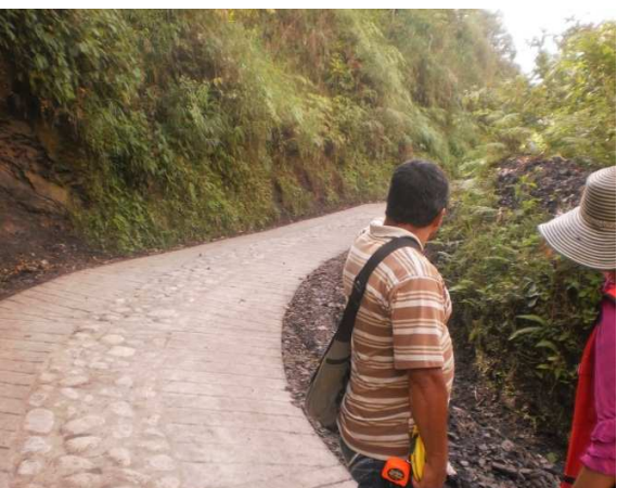
Tramo K3+370 Vía Plazuela Miradores
