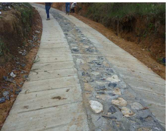
Tramo K1+400 Sector Pelicano
