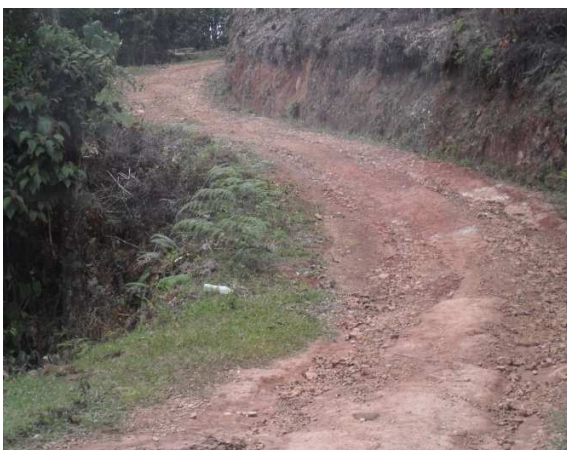
Tramo K7+100 Vía Piedra Blanca
