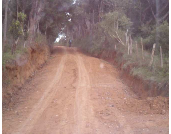
Tramo K0+500 Sector Mirador
