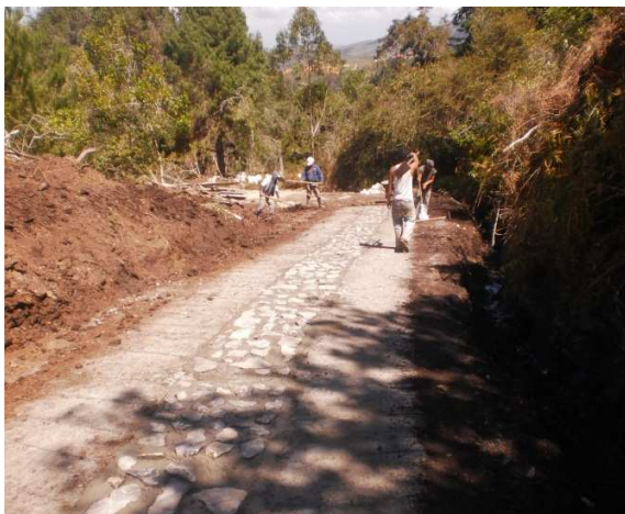
Tramo K0+500 Sector Pelicano
