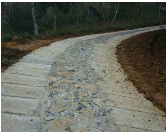
Tramo K1+900 Sector Pelicano
