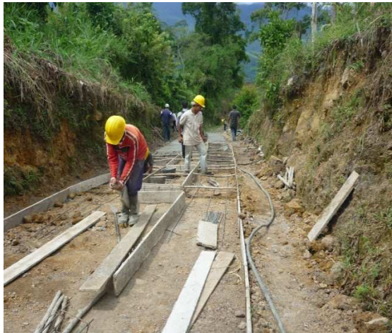
FOTO No 1: Colocación de formaletas
