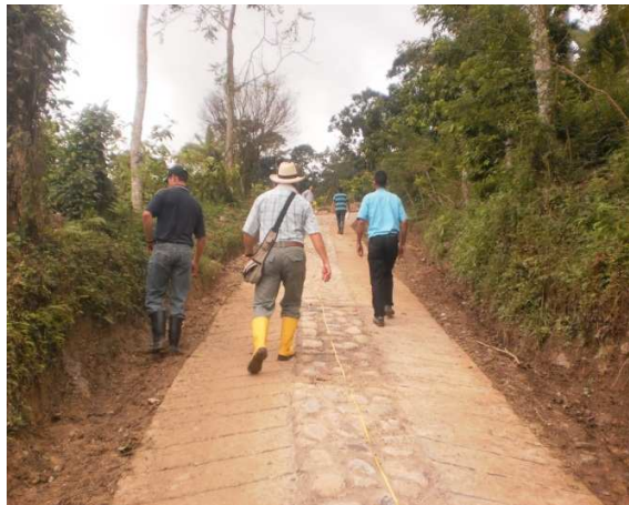
Tramo K1+590 Vía Plazuela - Miradores
