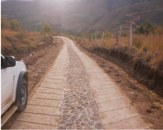
Tramo K0+500 Vía Piedra Blanca
