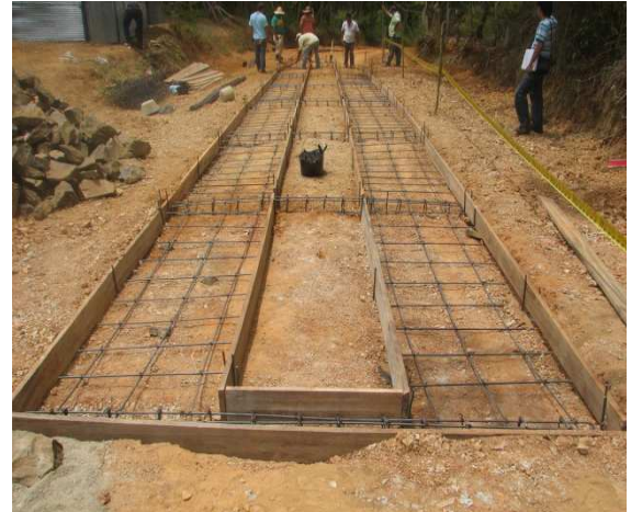
FOTO No 4: Terreno listo para fundir concreto
