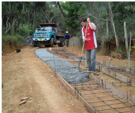
FOTO No 2: Extensión del concreto
