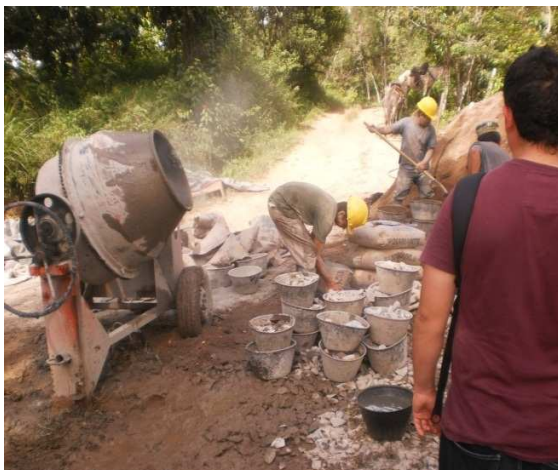
FOTO No 1: Dosificación de la mezcla
