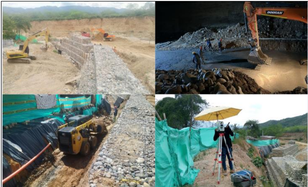
Figura 2 Fotografías tomadas en recorridos de obra
