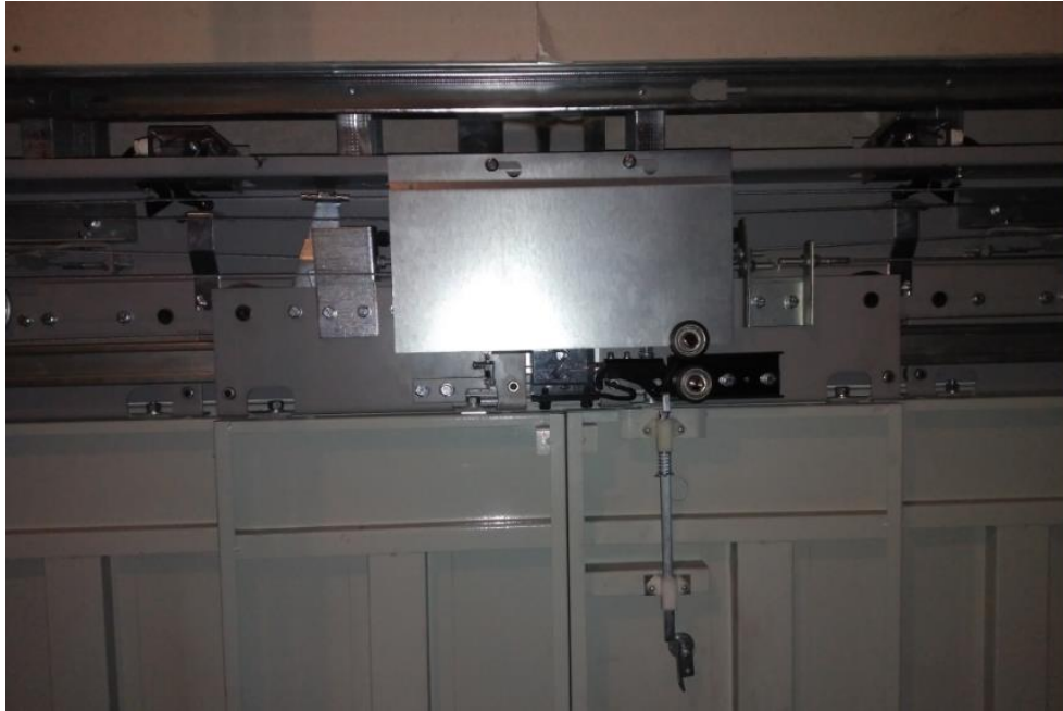
Figura 26. Enclavamiento mecánico
