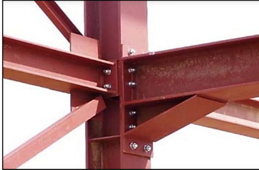
Figura 19. Ejemplo de una estructura atornillada.
