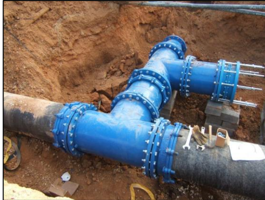
Figura 22. Tubería transportando agua.
