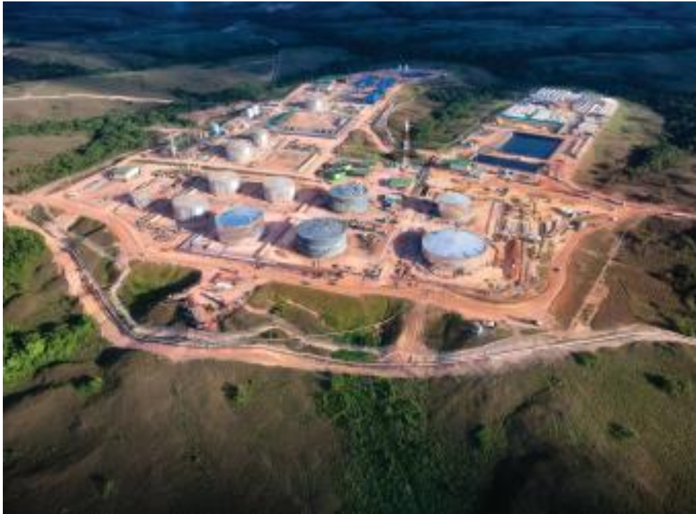
Figura 2. Batería 4, Centro de procesamiento de petróleo.
