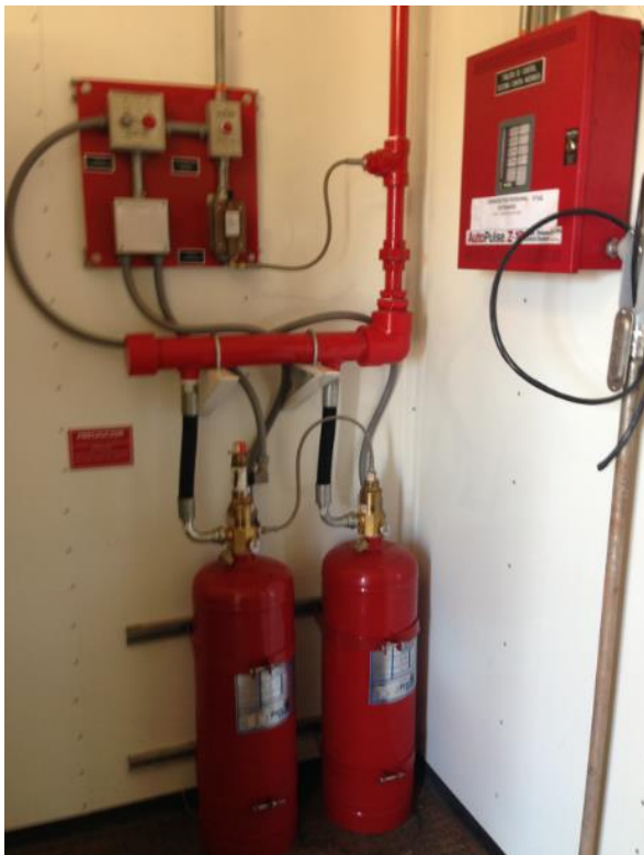
Figura 7. Sistema de Agente Limpio (SCI).
