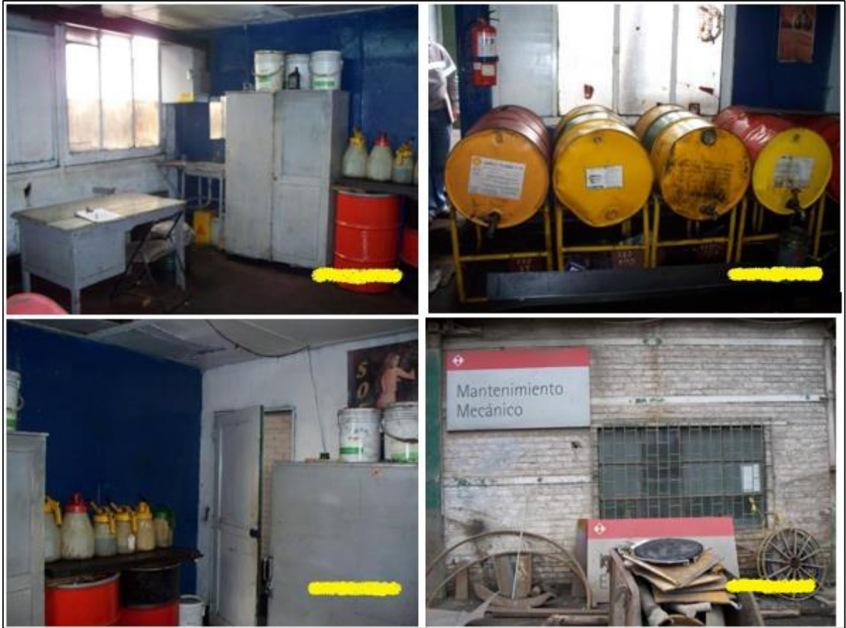
Ilustración 8. Collage de fotos del estado anterior del cuarto de lubricantes.
