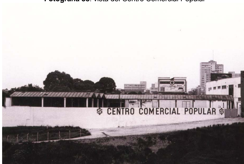
Fotografía 38A: vista del Centro Comercial Popular
