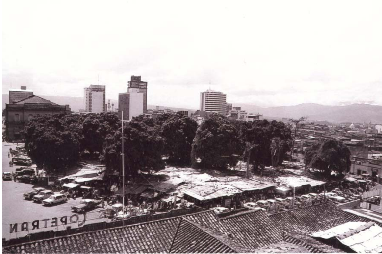
Fotografía 8: carrera 19 y 18 con calle 31 (parque centenario)
