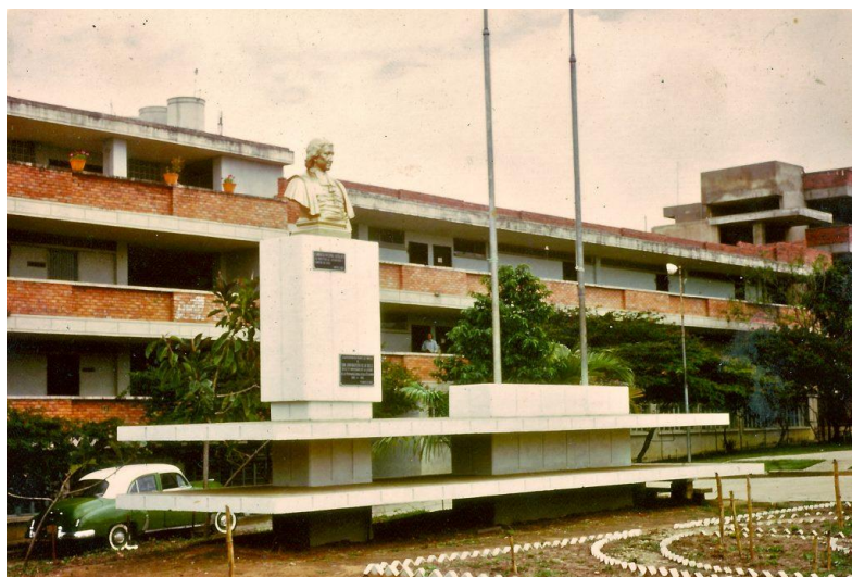
Figura 13. Planta física de Instituto Tecnológico Santandereano dentro de las instalaciones del Instituto Técnico Superior Dámaso Zapata
