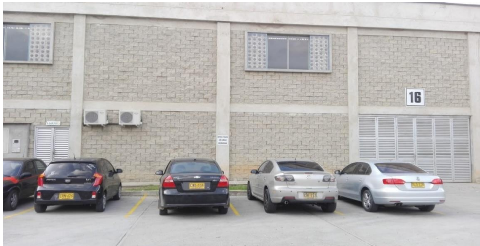
Figura 4. Fachada Distribuidora Lubrío SAS
