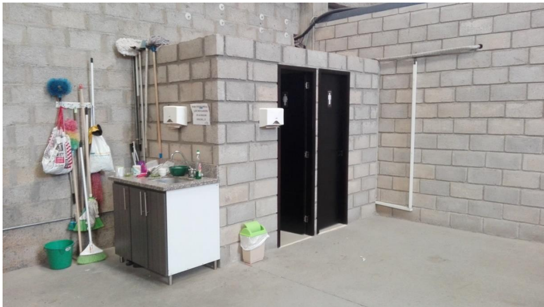
Figura 23. Zona de baños y aseo.
