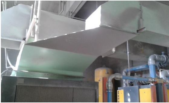
Figura 36. Ducto extractor de aire caliente cuarto de empaque
