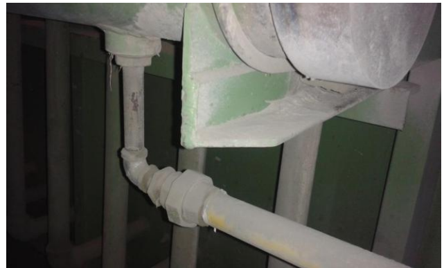
Figura 28. Reducciones y ampliaciones de diámetro en una misma línea en el área de empaque
