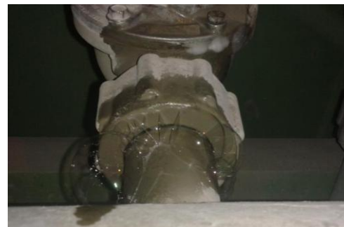
Figura 31. Pequeñas fugas en los empaques de las válvulas diafragma en el área de molienda de cemento y empaque.
