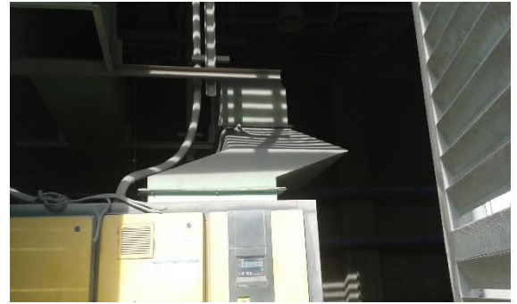
Figura 36. Ducto extractor de aire caliente cuarto de empaque
