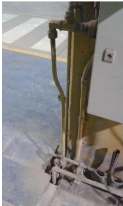
Figura 28. Reducciones y ampliaciones de diámetro en una misma línea en el área de empaque
