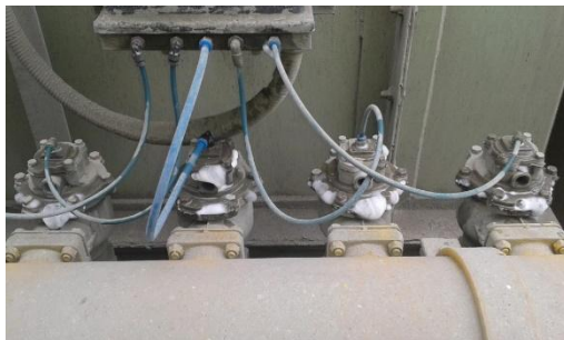
Figura 31. Pequeñas fugas en los empaques de las válvulas diafragma en el área de molienda de cemento y empaque.
