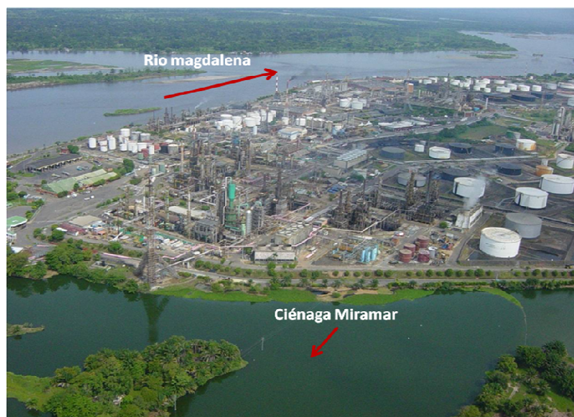
Figura 1. Vista general del departamento de refinación de crudos de la GRB
