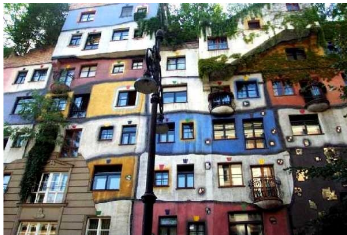
Figura 11. Fachada en edificios.
