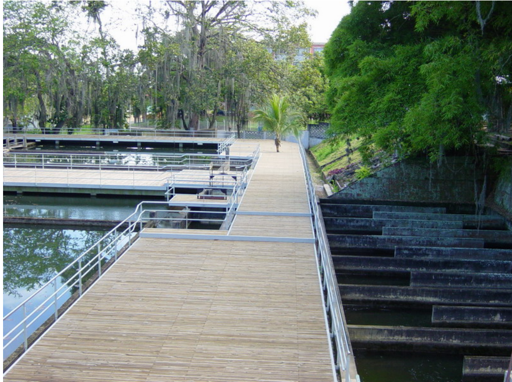
Figura 3. Panorámica de la Planta de Tratamiento de Agua Morrорico
