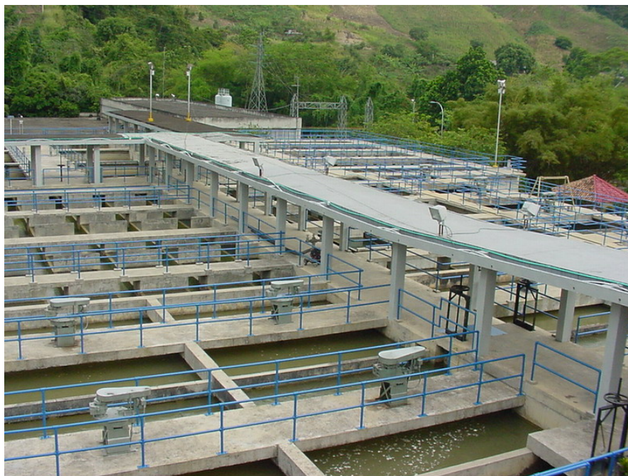
Figura 1. Panorámica de la Planta de Tratamiento de Agua Bosconia
