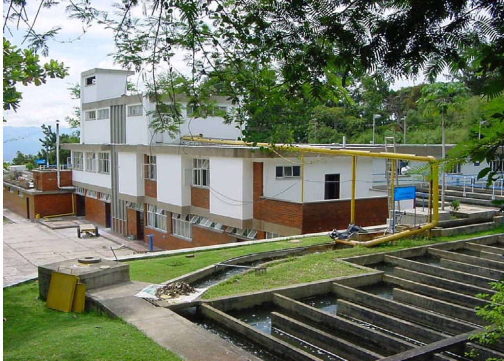
Figura 4. Panorámica de la Planta de Tratamiento de Agua Floridablanca
