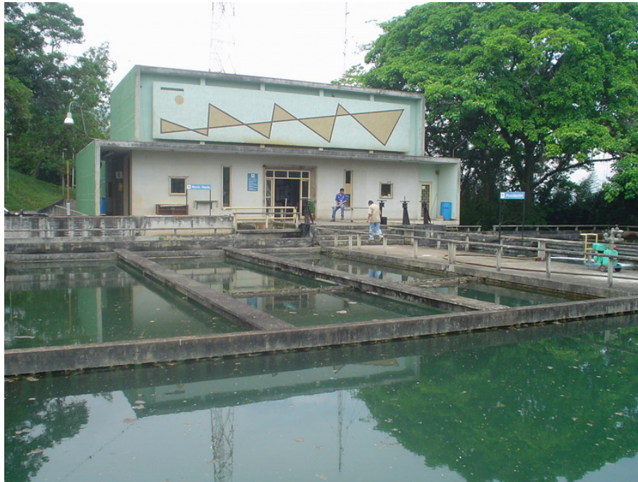
Figura 2. Panorámica de la Planta de Tratamiento de Agua La Flora
