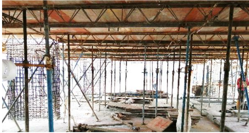
Figura 1. Armado de placa con sistema Jumping
