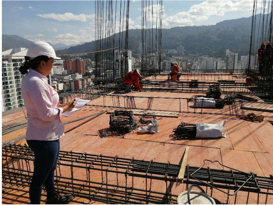
Figura 6. Chequeo del acero de refuerzo en vigas
