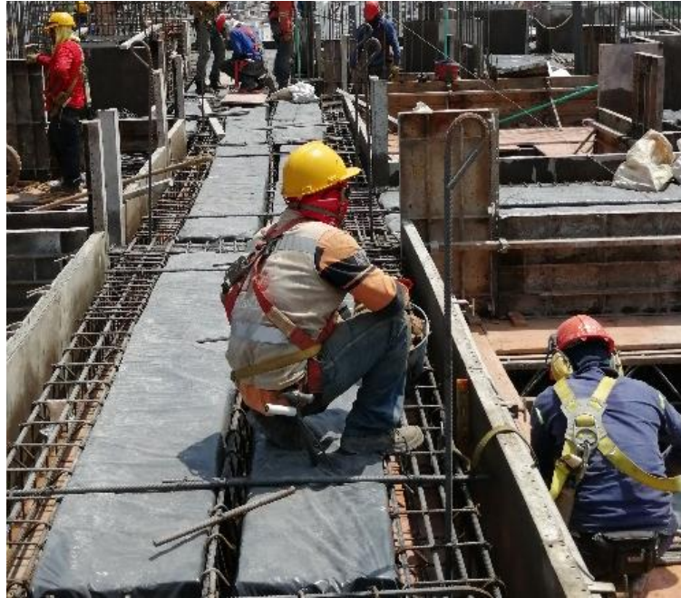
Figura 7. Instalación de formaleta para placa
