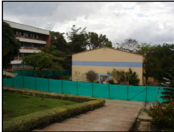
Figura 15. Estado inicial de la zona, Antiguo Gimnasio UIS
