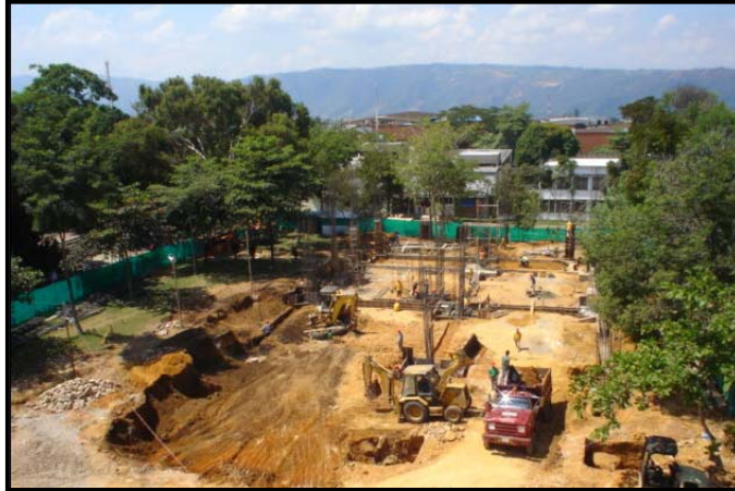
Figura 17. Ejes estructurales localizados y cimentación en construcción.
