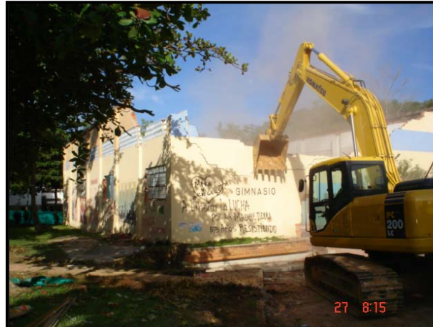
Figura 16. Demolición antiguo gimnasio UIS.
