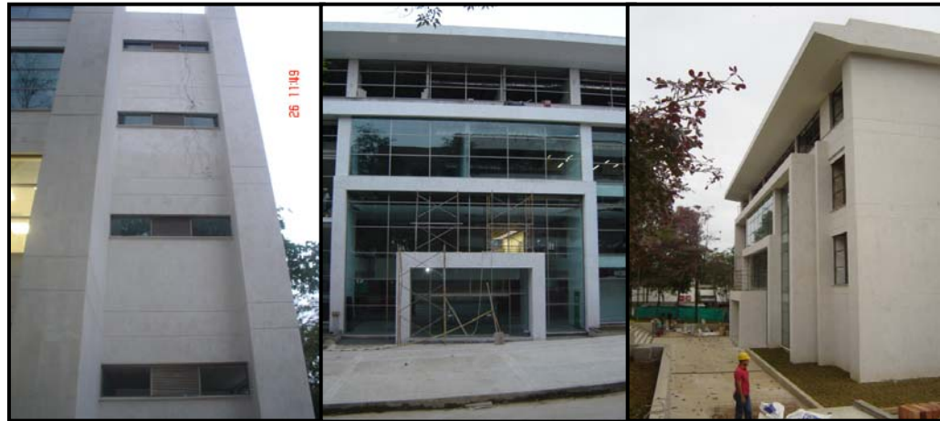
Figura 21. Fachada en piedra Bogota, fachada flotante.
