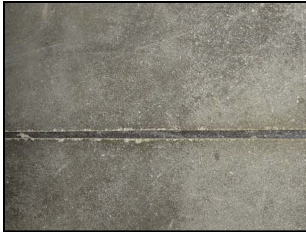
Figura 9. Dilatación de piso en mortero con endurecedor con cordón llenante.
