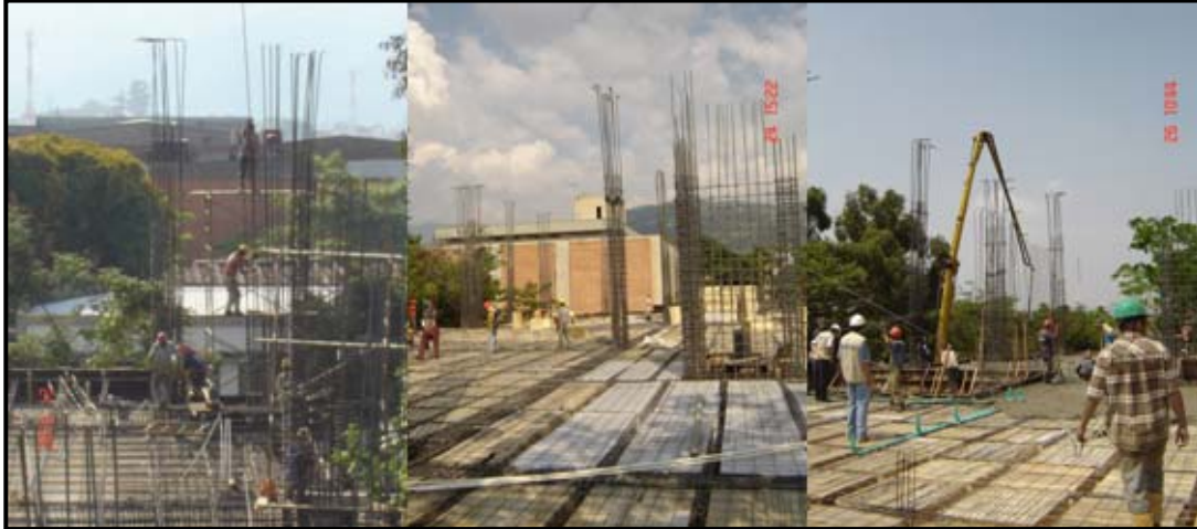
Figura 18. Armado de columnas segundo nivel, placa lista para fundir, fundida de placa.
