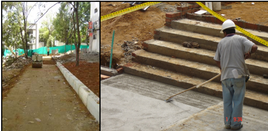
Figura 22. Zonas duras aledañas al edificio, compactación y cepillado.
