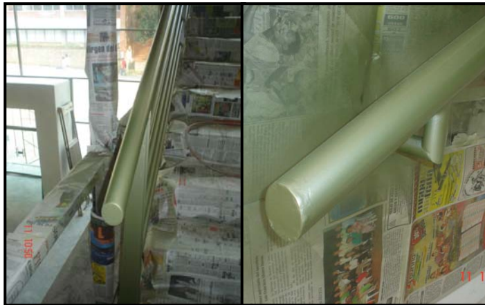
Figura 14. Pasamanos instalados para escaleras y zonas de doble altura.
