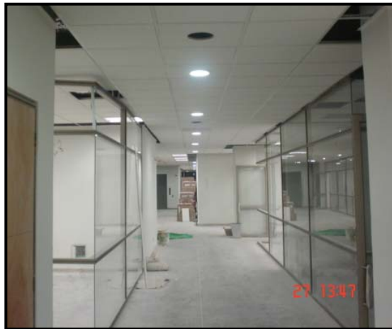
Figura 12. Ventanas y puerta ventanas en perfilería serie 45.
