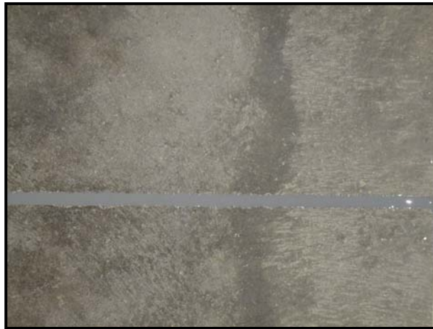
Figura 10. Dilatación de piso en mortero con endurecido terminada con junta epóxica tipo sikaflex 15.
