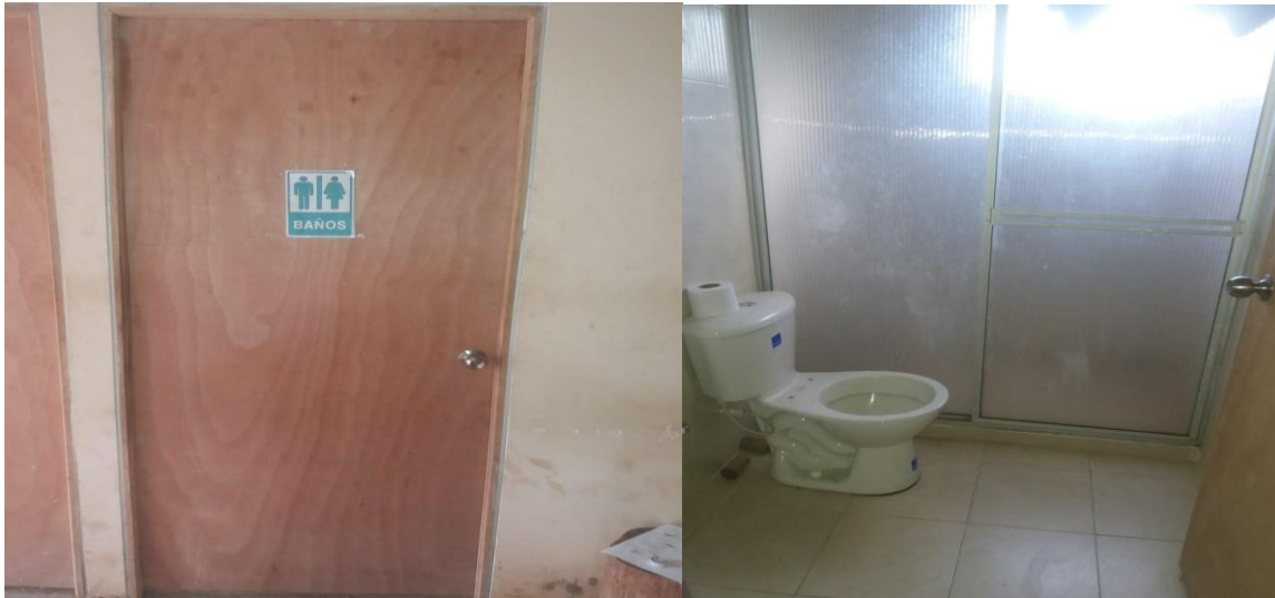
Figura 12. Baño para trabajadores, Fuente: autor
